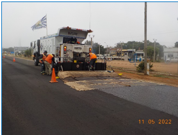
Ejecución de lechada asfáltica sobre tratamiento bituminoso simple en calzada de Ruta 27.
