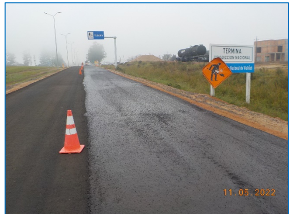
Ejecución de lechada asfáltica sobre tratamiento bituminoso simple en calzada de Ruta 27.
