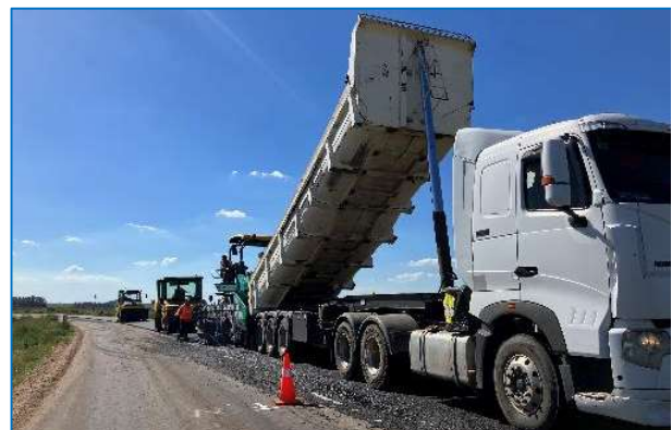
Pavimentación con sistemas ópticos de compensación para regularidad superficial.
