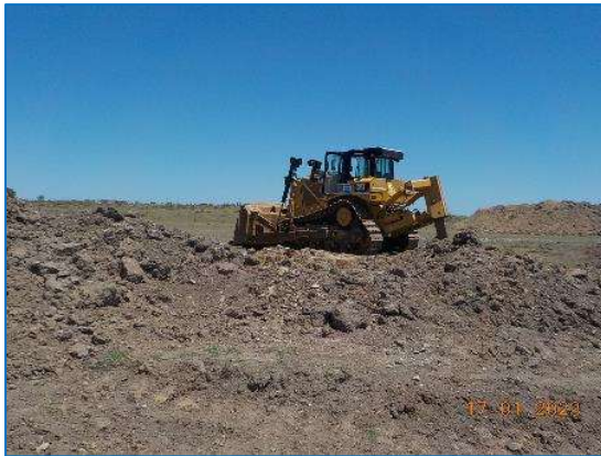
Arranque de tosca para recargo de calzada en siguiente trimestre.
