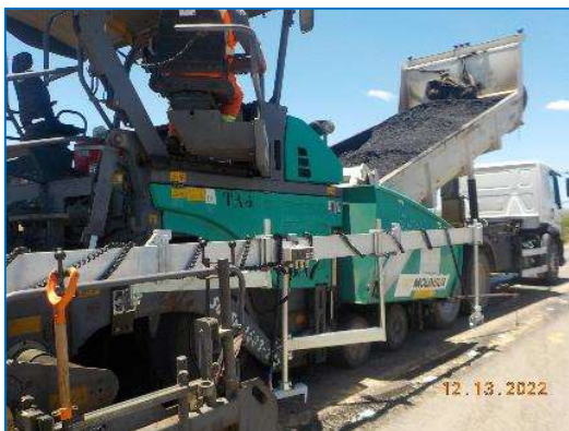
Pavimentación con sistemas ópticos de compensación para regularidad superficial.
