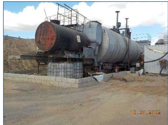
Recinto estanco para acopio en tanques.
