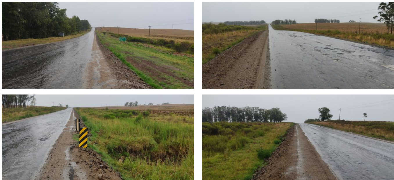
Foto 13.2-1 Vistas del tramo del contrato.
