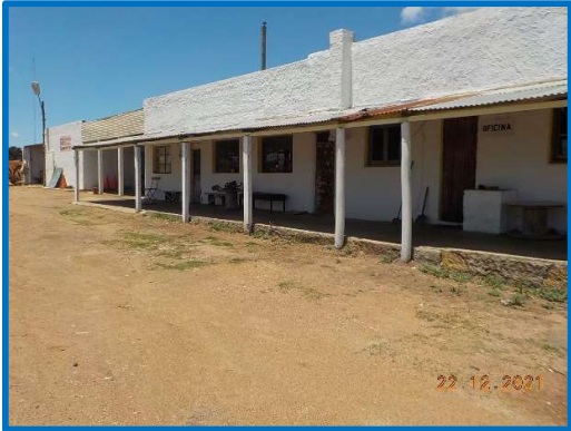
Instalaciones de Distrito de la Regional IV.
