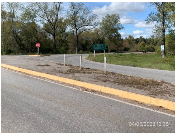
Ilustración 24 – P02, Fin de tramo. Ruta 20 progresiva 70K000, empalme con Ruta 3.
