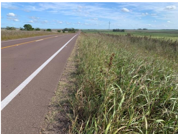
Ilustración 26 – Faja pública de Ruta 20 con condiciones adecuadas en su drenaje natural y tapiz vegetal.
