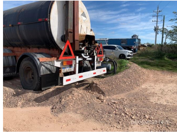
Ilustración 11 – P03, Obrador principal. Sector de almacenaje de emulsiones asfálticas con pavimento sin impermeabilizar y con vallado perimetral perforado.
