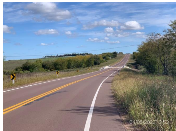
Ilustración 25 – Tramo de Ruta 20 terminado y abierto al tránsito.
