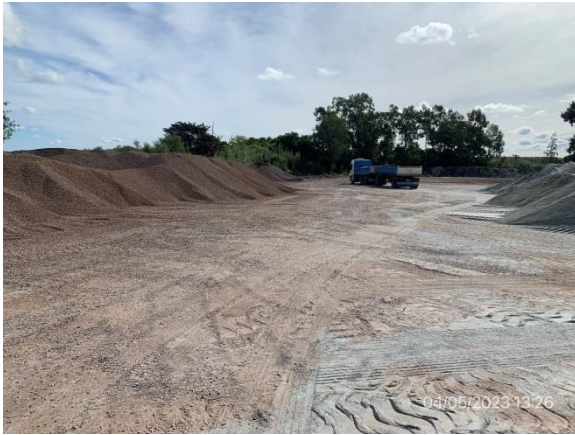
Ilustración 10 – P05, Planta asfáltica. Explanada de acopio de áridos.
