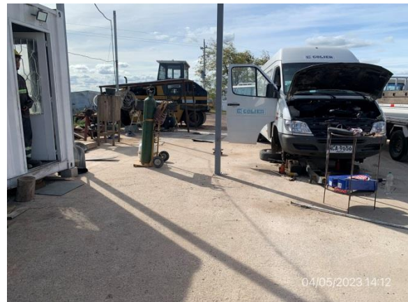
Ilustración 13 – P03, Obrador principal. Taller mecánico a cielo abierto con pavimento impermeable.
