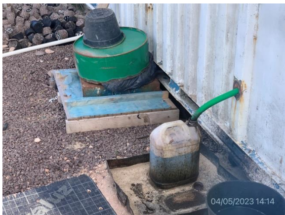
Ilustración 20 – P03, Obrador principal Acopio de perclorotileno usado en tarrina con vallado perimetral.
