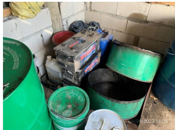
Ilustración 15 – P03, Obrador principal. Acopio de baterías en sector con pavimento y vallado impermeable.
