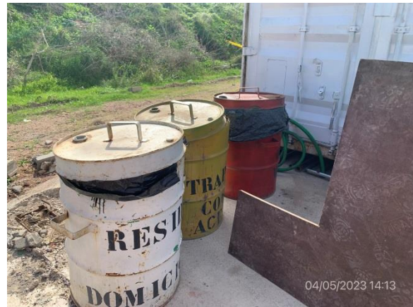
Ilustración 17 – P03, Obrador principal. Acopio de residuos segregados por corriente de generación.
