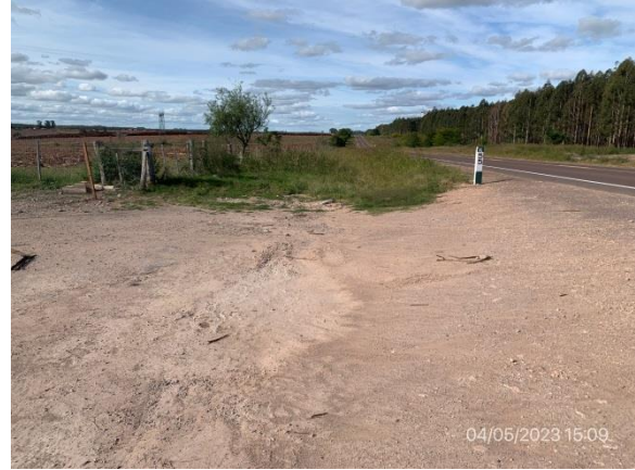
Ilustración 17 – P04, Obrador principal acceso a Ruta 20 con pavimento granular compactado a beneficio del propietario.
