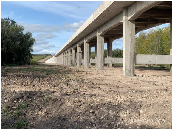
Ilustración 8 – P02, Puente sobre A° Don Esteban. Obra terminada y abierta al tránsito.
