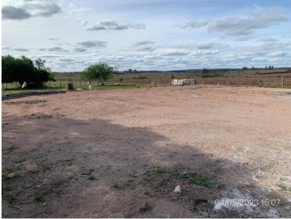
Ilustración 16 – P04, Obrador principal desmontado. Plataforma compactada a beneficio del propietario.
