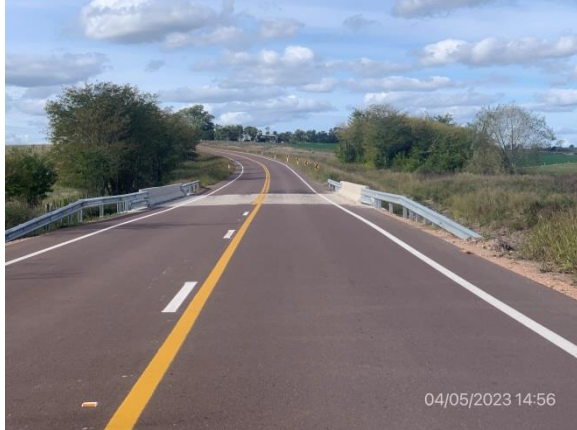
Ilustración 4 – P03, Puente sobre C da del Rosario. Obra terminada y abierta al tránsito.
