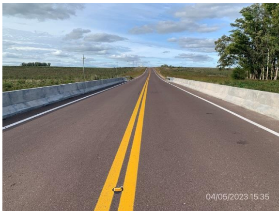
Ilustración 12 – P01, Puente sobre C da del Sauce. Obra terminada y abierta al tránsito.
