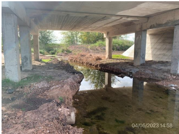
Ilustración 6 – P03, Puente sobre C da del Rosario. Curso de agua limpio y sin ROCs u otros residuos.
