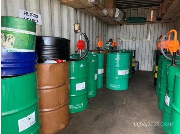
Ilustración 4 – P03, Obrador. Acopio de lubricantes y residuos contaminados en local cerrado.
