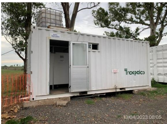
Ilustración 8 – P03, Obrador. Baños con conexión a depósito impermeable.
