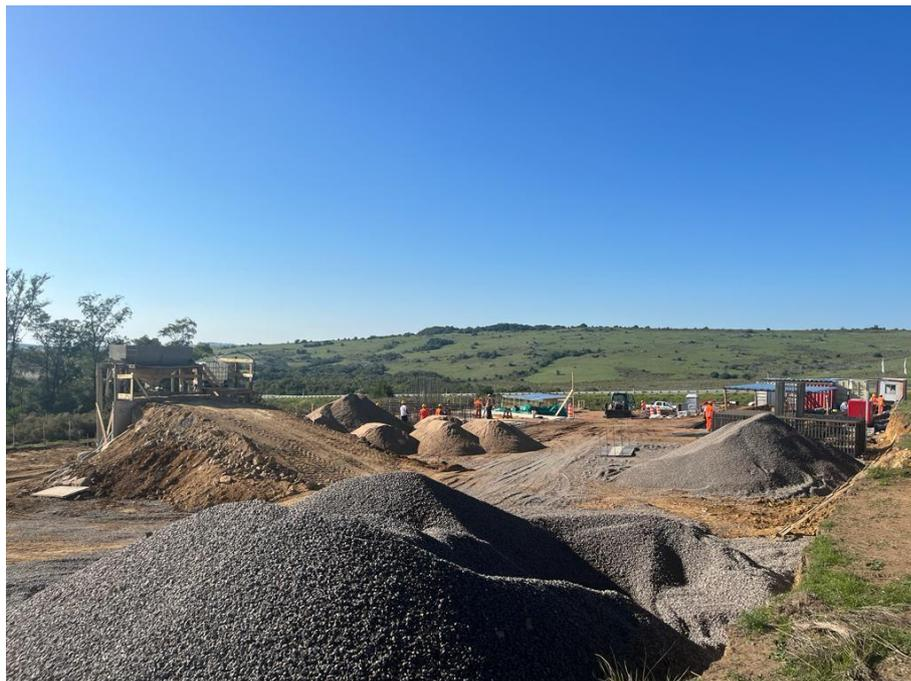
Imagen N°9: Acopios de materiales granulares para hormigón.
