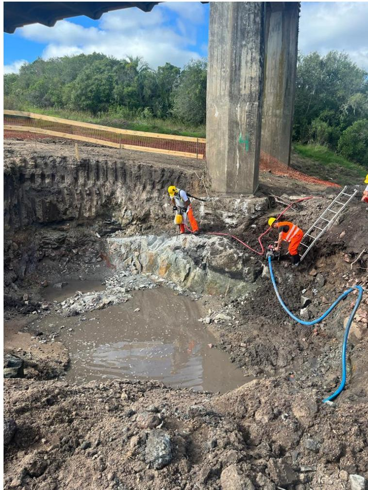
Imagen N°10: Excavación para base de fundación
