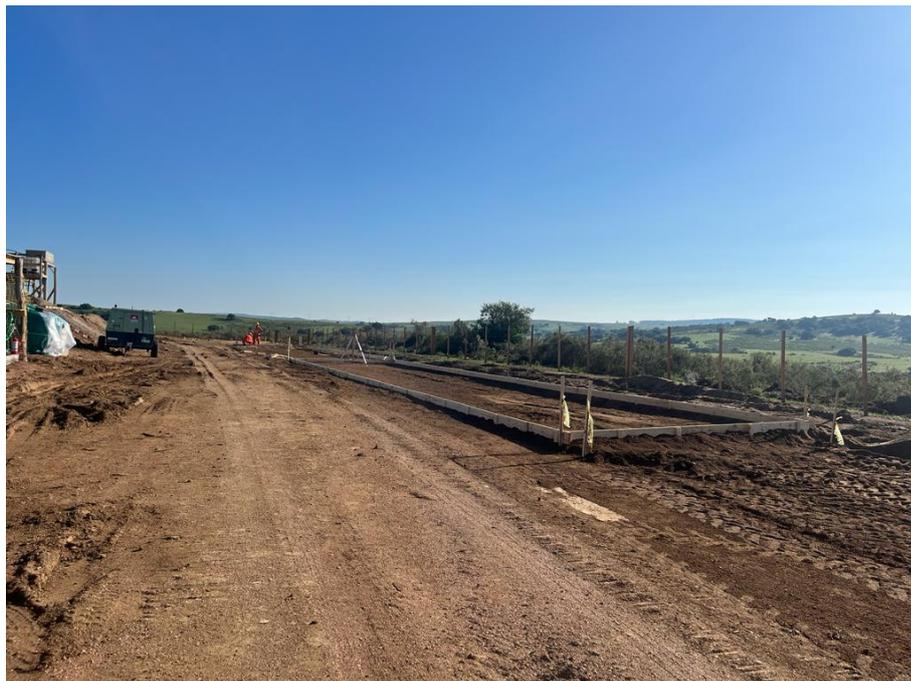
Imagen N°7: Preparación de área para vigas premoldeadas.
