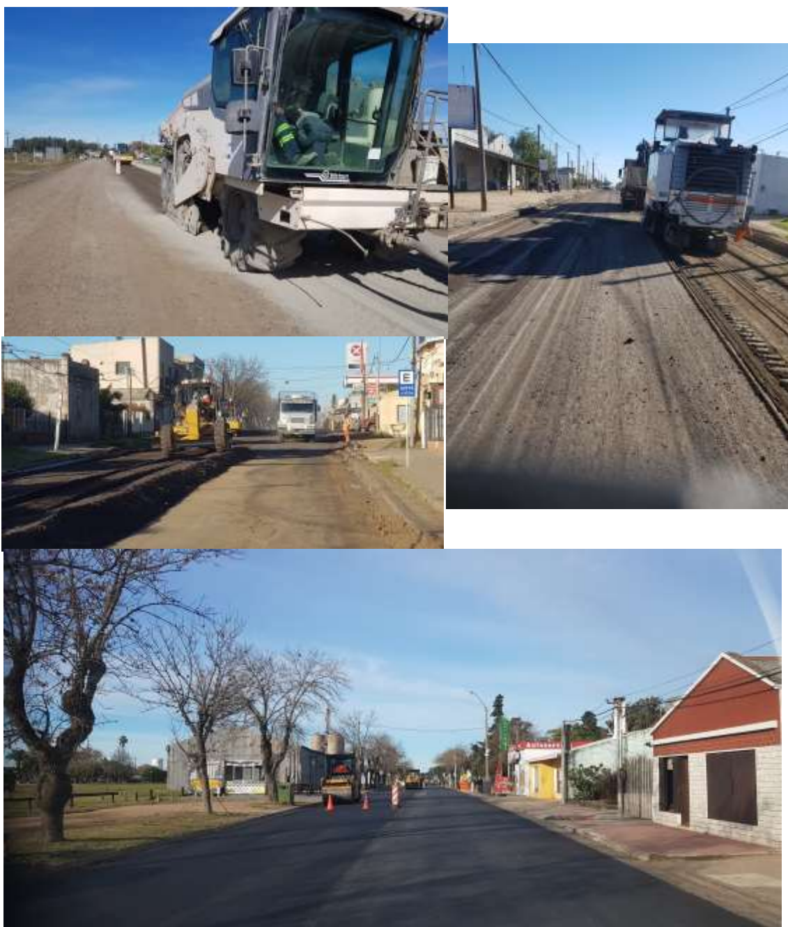
Vistas del frente de obra
