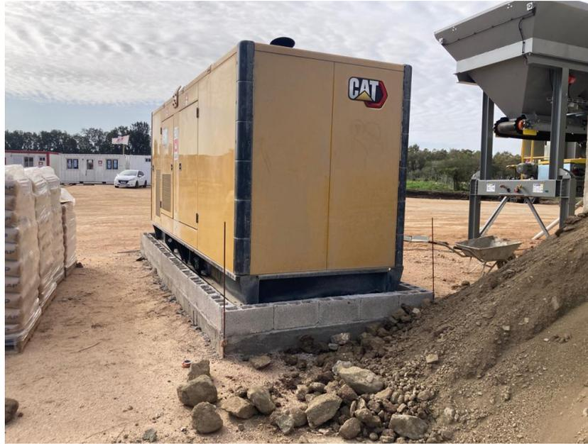
Imagen N°9: Generador con bandeja impermeable.
