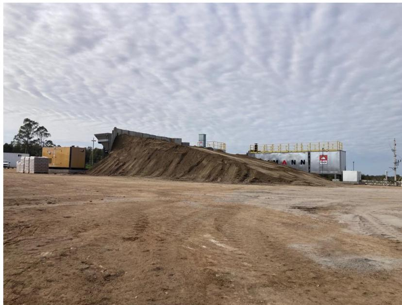
Imagen N°5: Rampa para carga de tolva de áridos de Planta Asfáltica.
