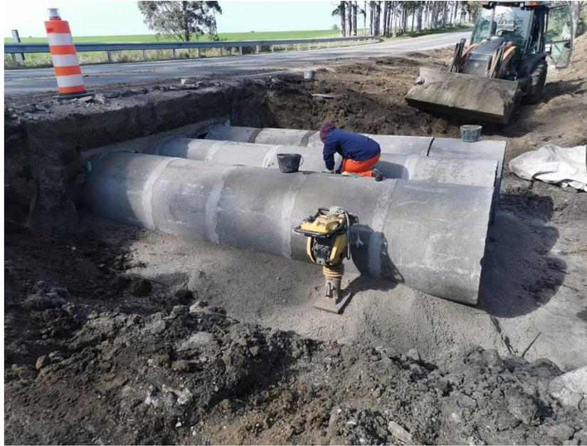
Imagen N°10 y 11: Alargue de alcantarillas con caños de 1000 mm.
