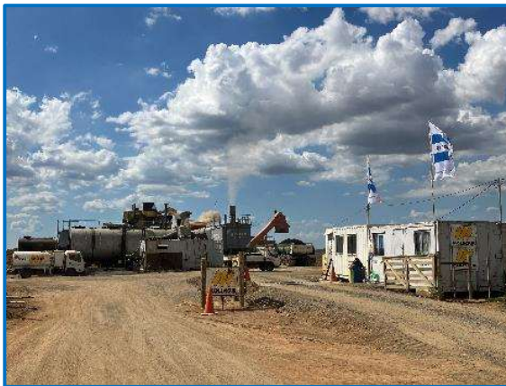
Acceso a la planta de elaboración de Mezcla Asfáltica.
