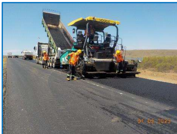
Extendido y compactación de la mezcla asfáltica en caliente.
