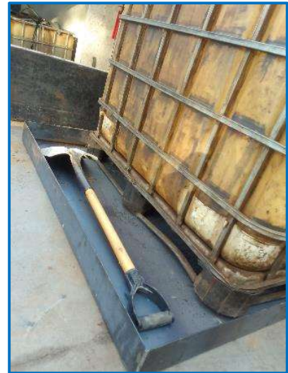
A comienzos del trimestre se implementó bandeja estanca para eventual contención de hidrocarburos.
