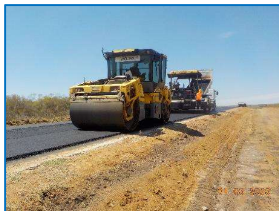
Extendido y compactación de la mezcla asfáltica en caliente.
