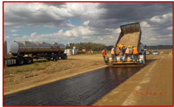
Actividades de curado de la base estabilizada con cemento.
