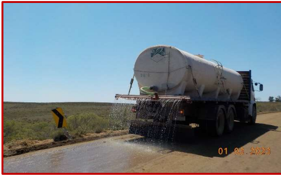
Actividades de curado de la base estabilizada con cemento.
