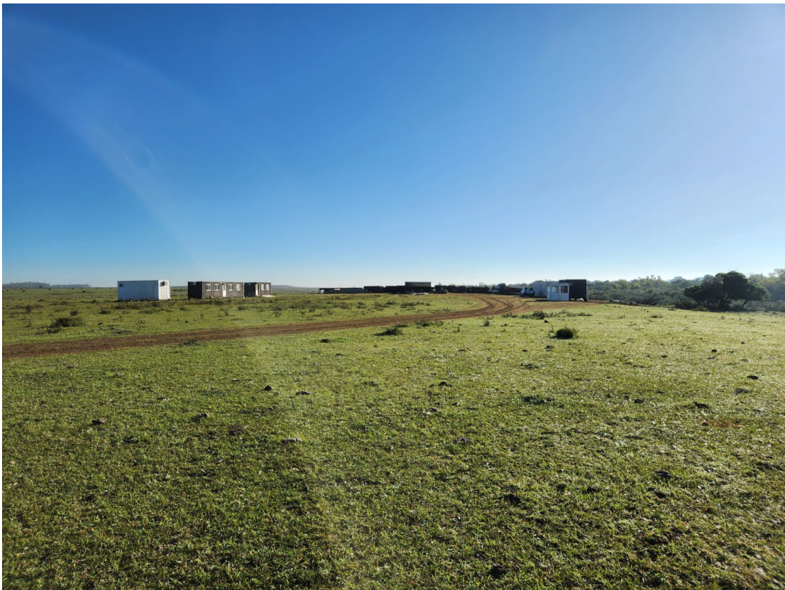
Imagen 2 – Instalación del obrador
