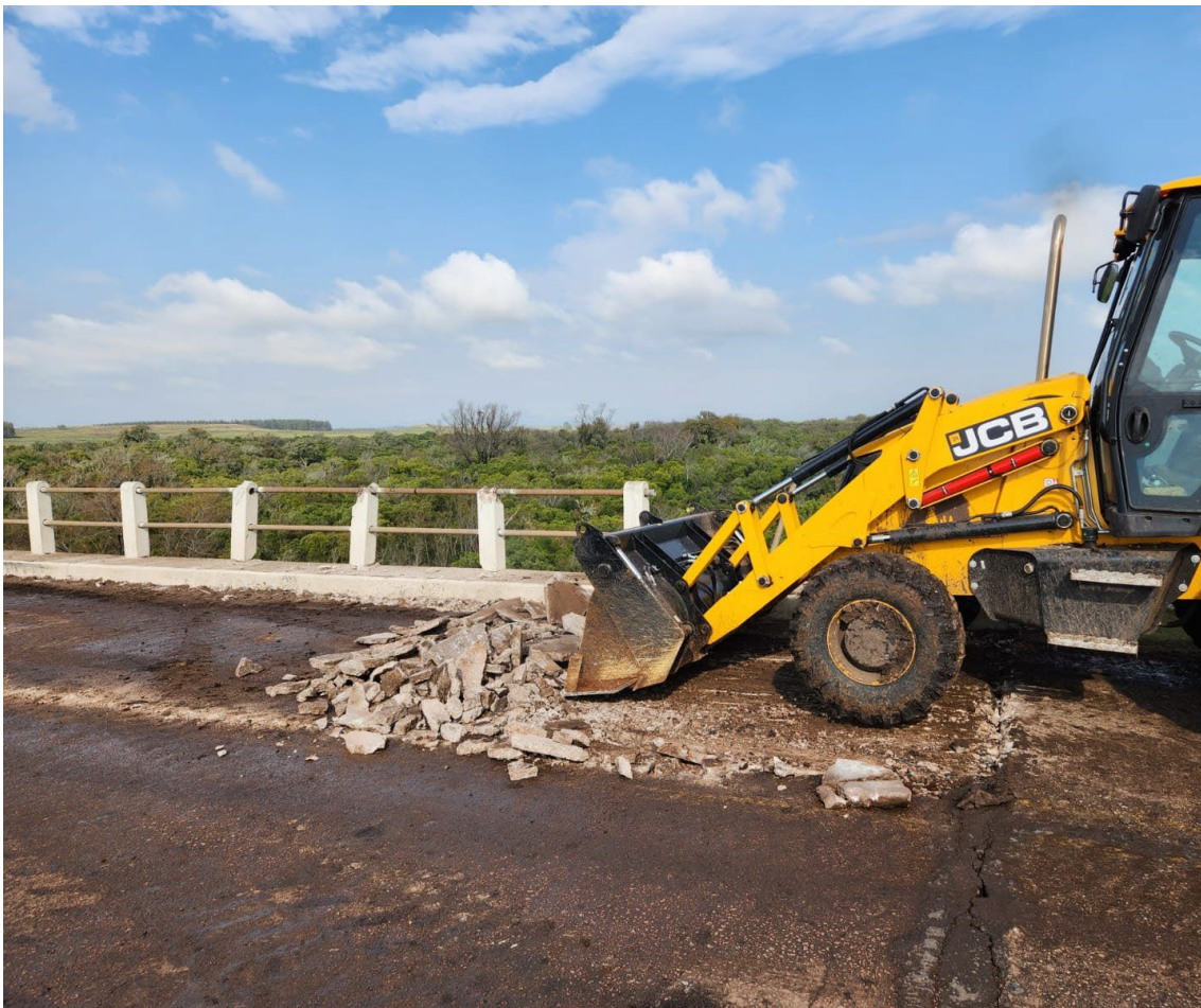
Imagen 7 – Extracción de capa de rodadura en puente sobre Arroyo Salsipuedes
