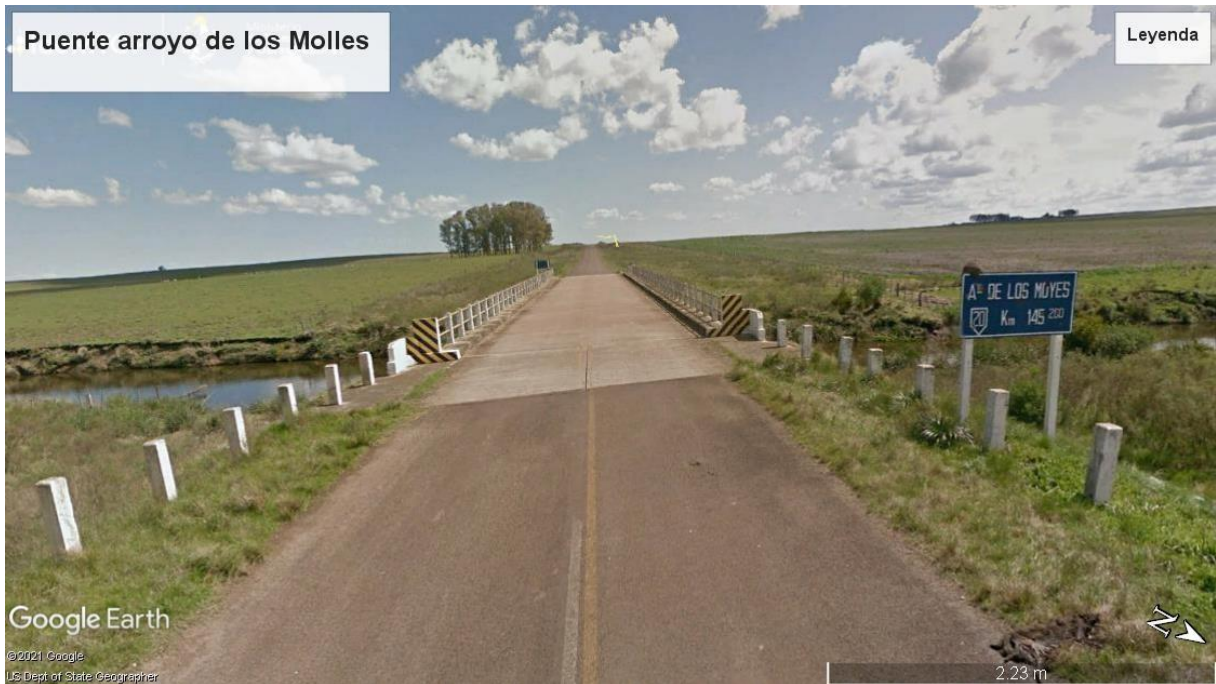
Ilustración 2-1 Situación actual Puente arroyo de los Molles
