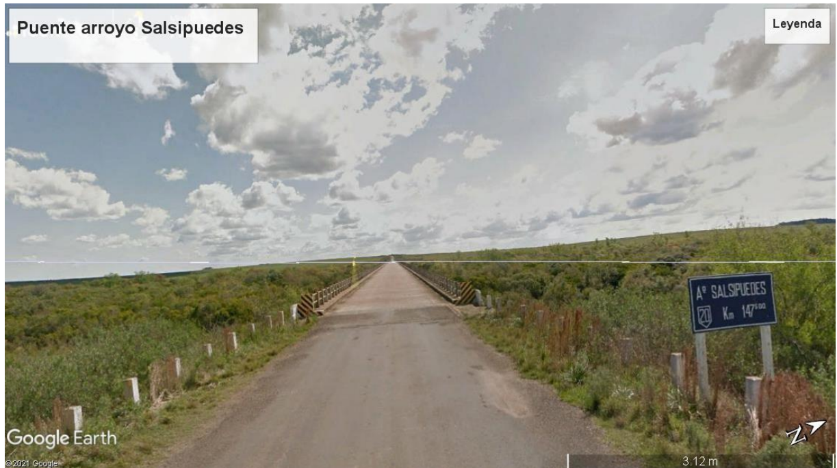
Ilustración 2-5 Situación actual puente arroyo Salsipuedes
