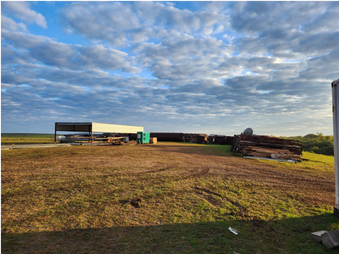
Imagen 1 – Instalación del obrador
