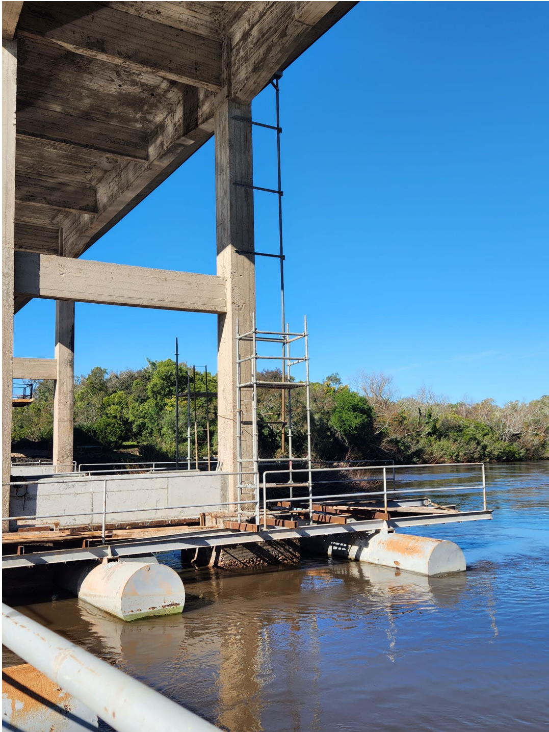
Imagen 6 – Trabajos en fundaciones del puente sobre Arroyo Salsipuedes
