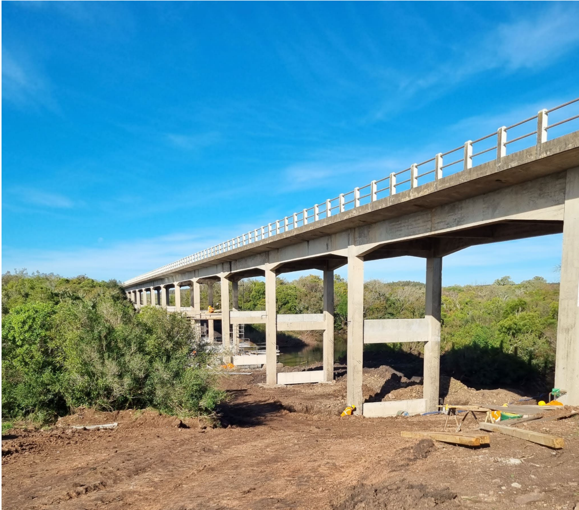
Imagen 8 – Trabajos en fundaciones en puente sobre Arroyo Salsipuedes
