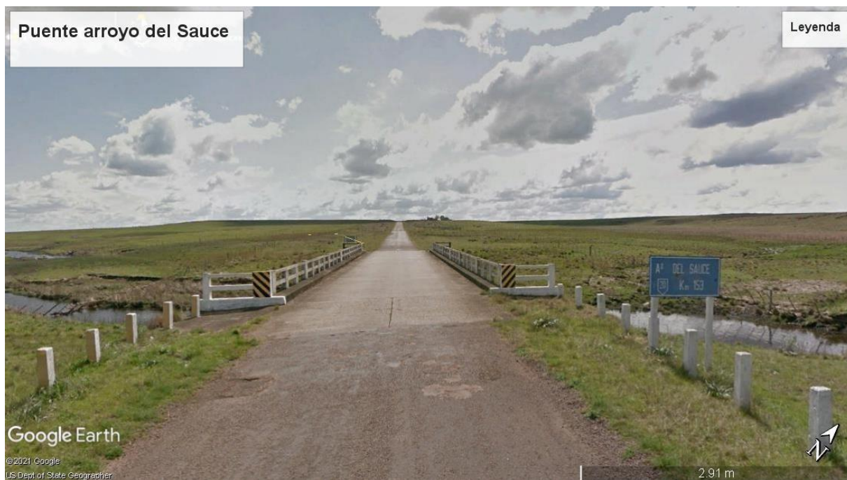
Ilustración 2-3 Situación actual puente arroyo del Sauce
