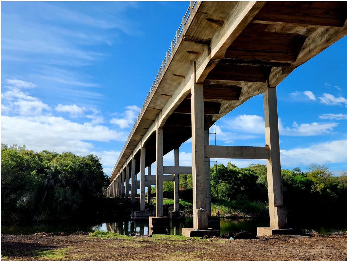
Imagen 5 – Puente sobre Arroyo Salsipuedes
