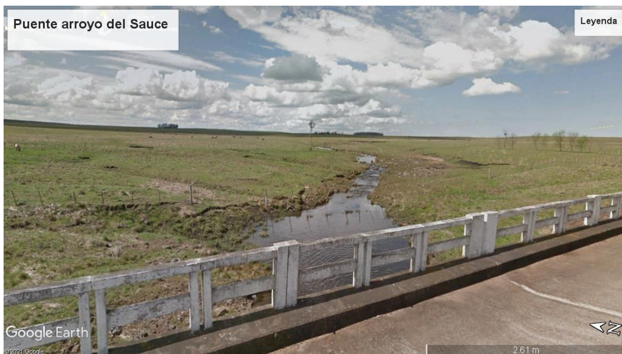
Ilustración 2-4 Cauce arroyo del Sauce
