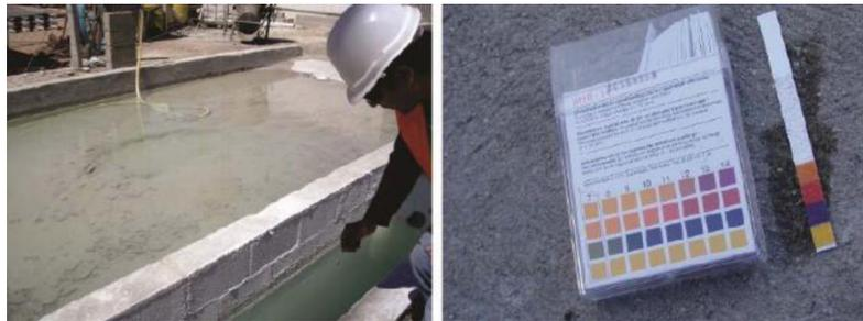
Figura 7-4: Ejemplo de medición de pH en efluentes de hormigón, utilizando cintas de pH.
