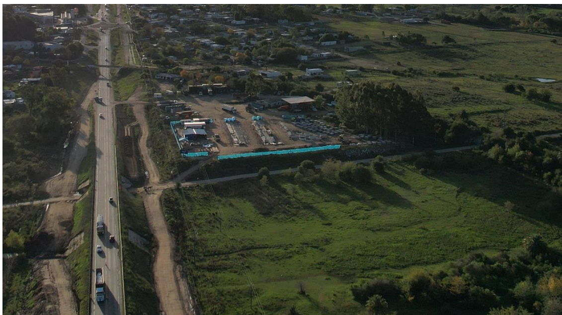
Figura 2-2 Área de prefabricados de hormigón armado e imagen drone del obrador
