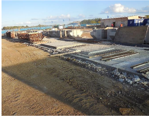
Figura 3-5 Platea para piezas prefabricadas de hormigón armado
