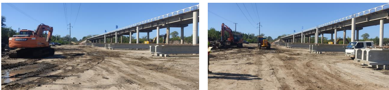
Foto 13.2-1 Entorno de obra Pte. Río Santa Lucía - Ruta 5.
