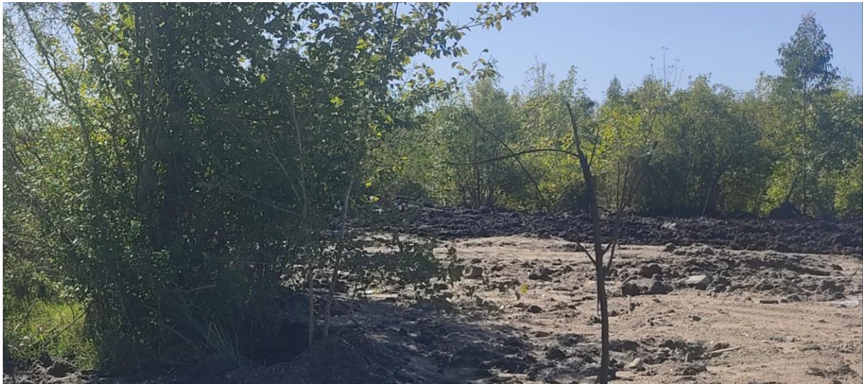
Foto 13.1-1 Retiro de vegetación de monte del entorno del puente
