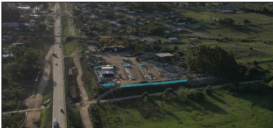
Figura 2-2 Prefabricados de hormigón armado e imagen aérea del obrador
