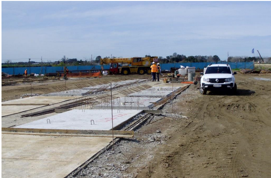
Figura 3-5 Platea para piezas prefabricadas de hormigón armado
