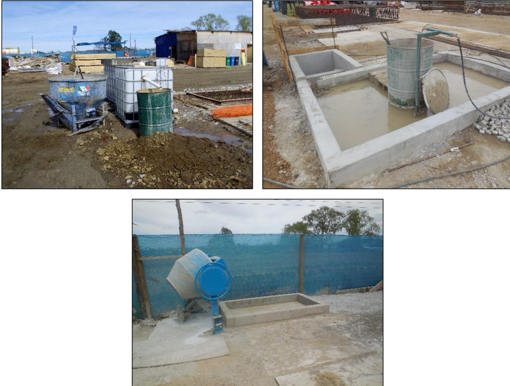
Figura 3-10 Sistemas de lavado y tratamiento efluente de hormigón en obra.
