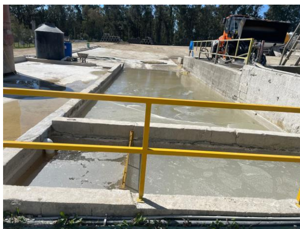
Pileta de lavado – Vialmix
