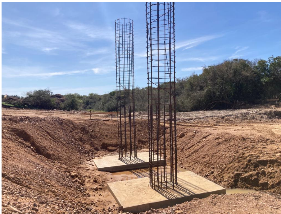
Imagen N°8: Pilares hormigonados.
