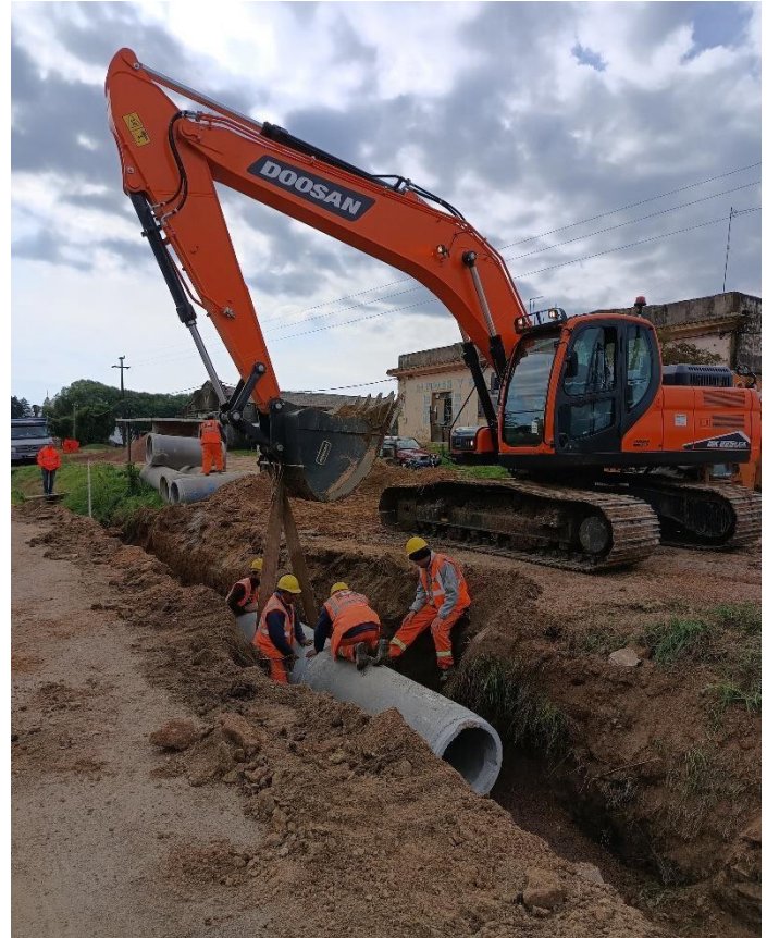
Re- construcción de alcantarillas sobre ruta 63
