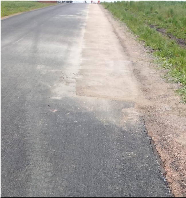
Reparaciones en baches sobre ruta 86
