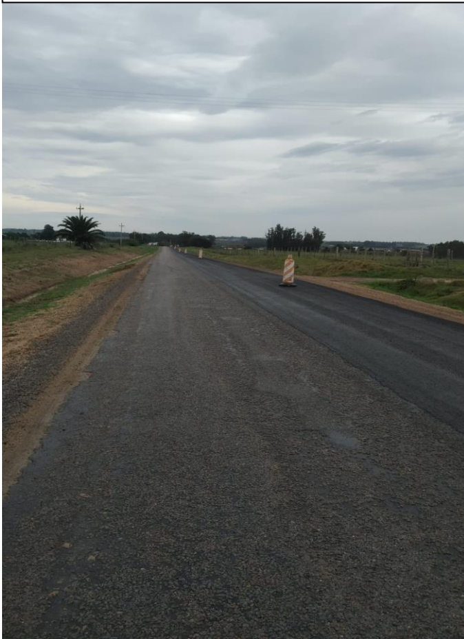
Lechada asfáltica en ruta 86
