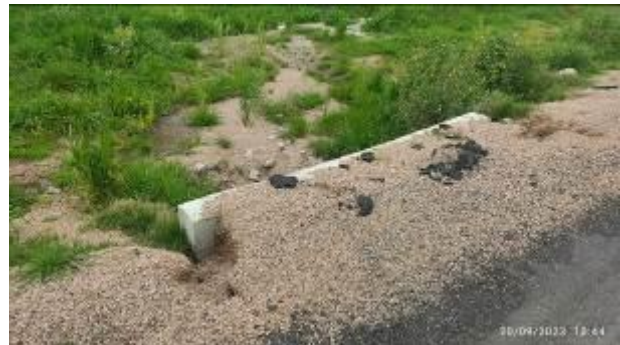
Foto 12.4-1 Restos de materiales y erosión en alcantarilla de Ruta 86.
