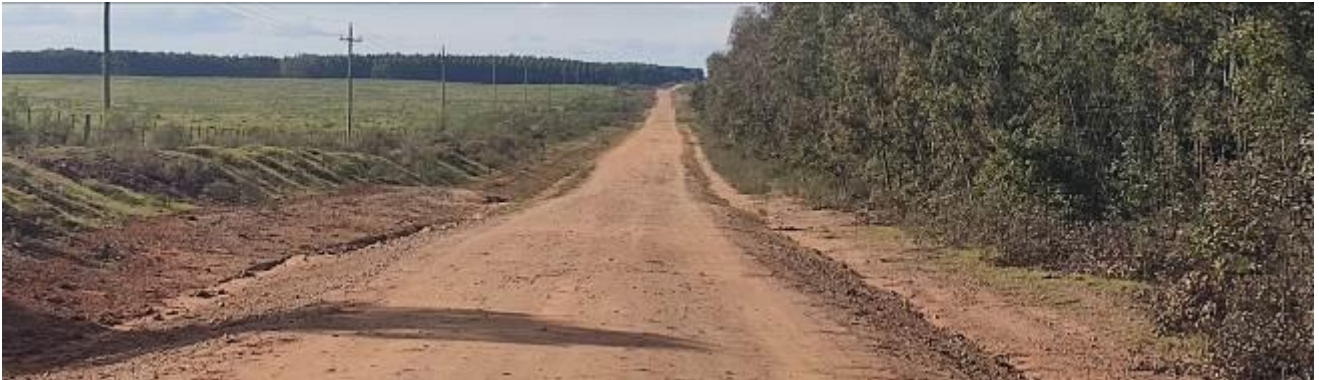
Foto 12.1-1 Tramo del inicio del tramo del contrato.
