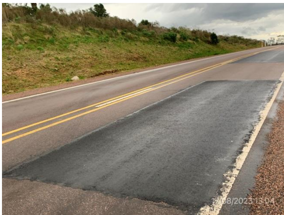
Foto 12.1-3 Obras obligatorias de bacheo ejecutadas en Ruta 87, senda a (-).
