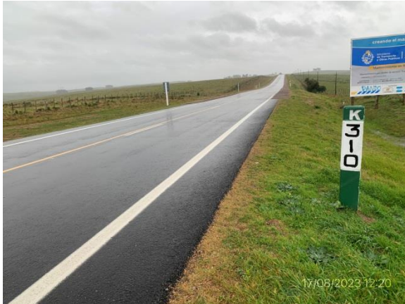
Foto 12.1-1 P01, inicio de tramo. Ruta 8, progresiva 310 K000.
