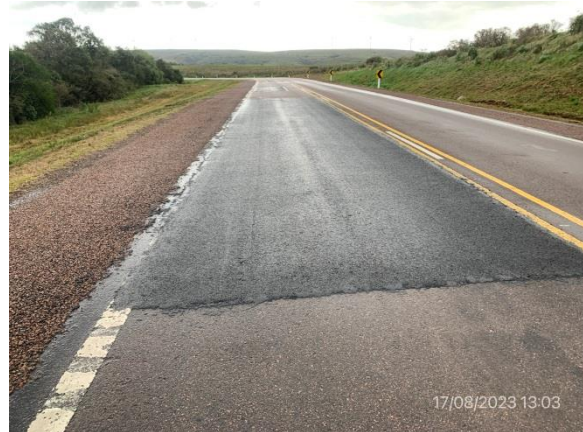
Foto 12.1-2 Obras obligatorias de bacheo ejecutadas en Ruta 87, senda a (+). Señalización horizontal afectada
