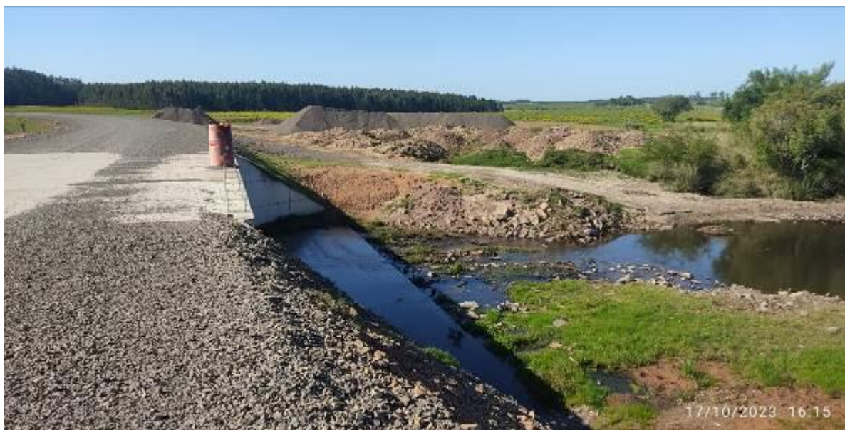
Foto 12.1-1 Acopio en zona con riesgo de inundación.
