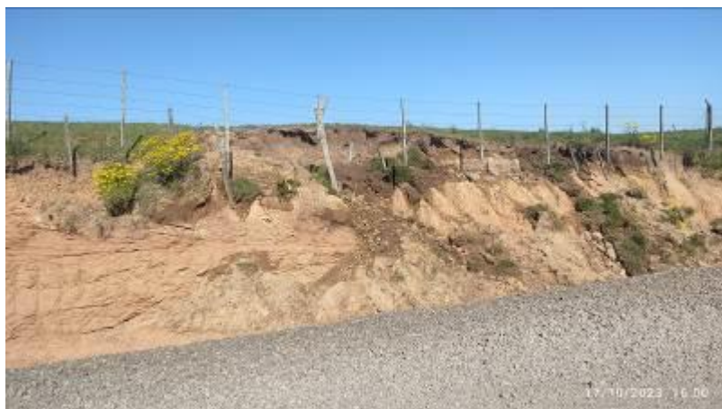
Foto 12.2-1 Erosiones en taludes de faja.
