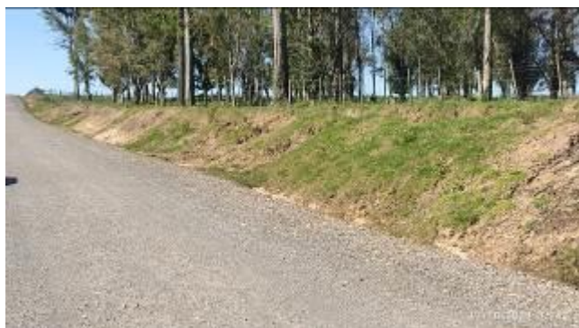
Foto 12.1-1 Erosión en talud de faja.
