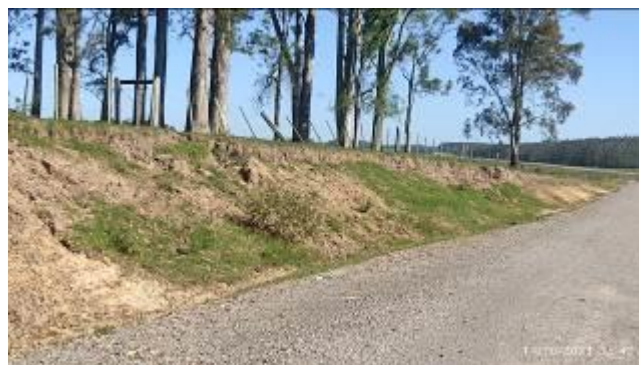
Foto 12.1-1 Erosión en talud de faja.
