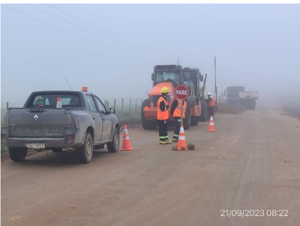
Foto 12.1-5, P05. Frente de obras de bacheo y ensanche de plataforma. Ruta 6 progresiva 189K500.
