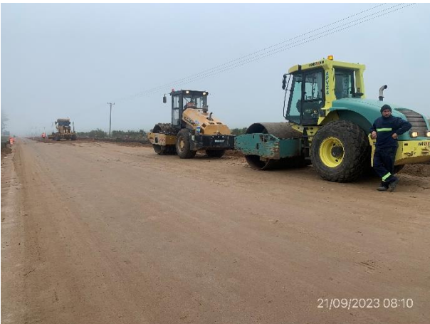
Foto 12.1-3. P04, Frente de obras de recargo granular. Ruta 6 progresiva 194K000
