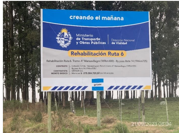
Foto 12.1-2. P01. Inicio de tramo. Ruta 6 PK 194K475.
