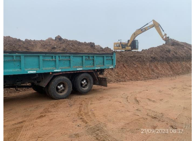
Foto 12.2-2, Cantera y obrador en proceso de montaje. Ruta 6 progresiva 185K000 a (-). Aún no se instalaron estaciones de residuos cercanos al frente de explotación.
