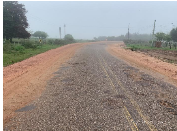
Foto 12.1-4. Ruta 6, tramo de obra con bacheo y ensanche de plataforma ejecutados
