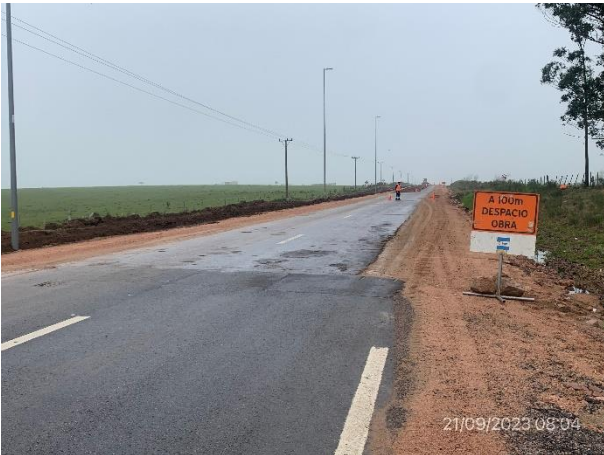
Foto 12.1-1, P01. Inicio de tramo. Ruta 6 PK 194K475
