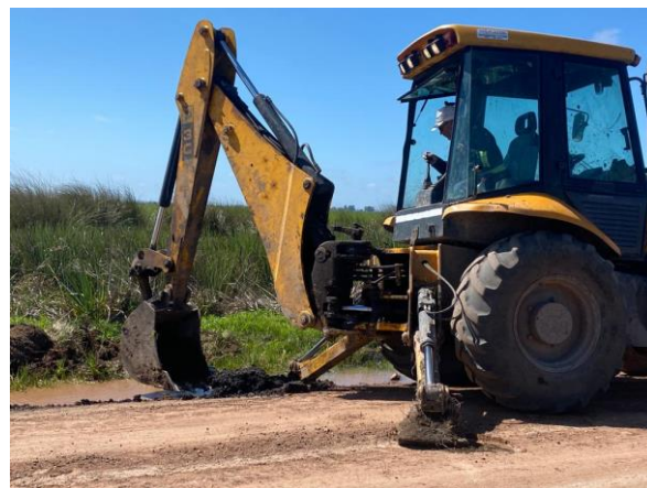
Foto 12.2-2. P03.Campamento Móvil en frente de obra. Tareas de limpieza en ejecución
