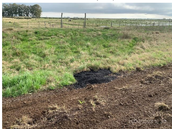
Foto 12.1-10. Acopio de RAP sobrante en faja pública de Ruta 19.
