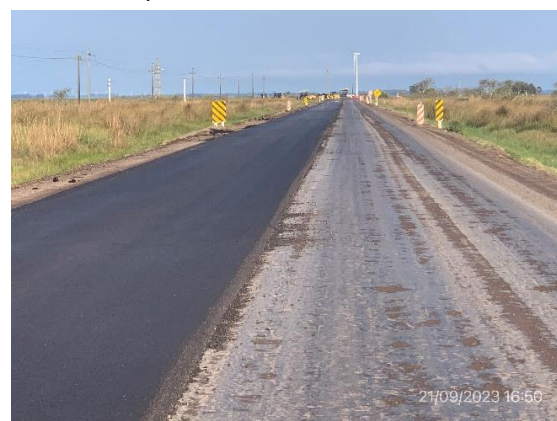
Foto 12.1-4, P02. Tramo de ruta con carpeta asfáltica terminada en media calzada.
