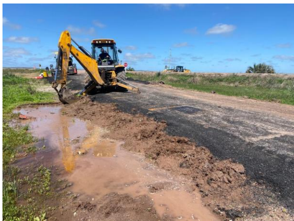
Foto 12.2-1, P03.Campamento Móvil en frente de obra. Tareas de limpieza en ejecución
