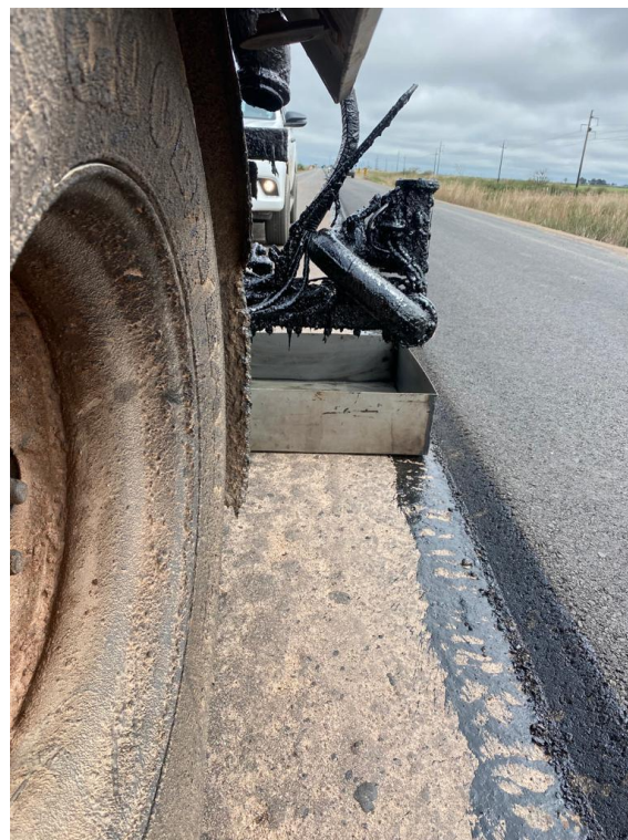
Foto 12.2-6, P03. Se colocó bandeja estanca evitando derrames en camión regador de emulsión
