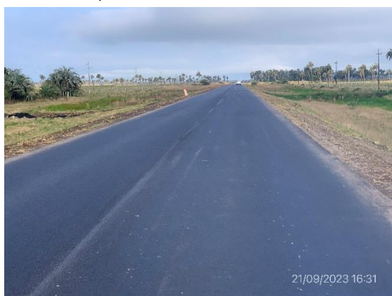
Foto 12.1-3. Tramo de ruta con carpeta asfáltica terminada en sendas a (+) y a (-)
