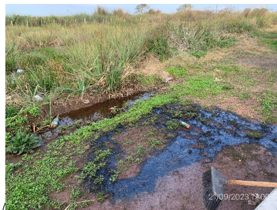
Foto 12.1-8, P03, Frente de obra. Derrame de emulsión asfáltica a cuneta inundada, camión regador de emulsión no cuenta con bandeja impermeable
