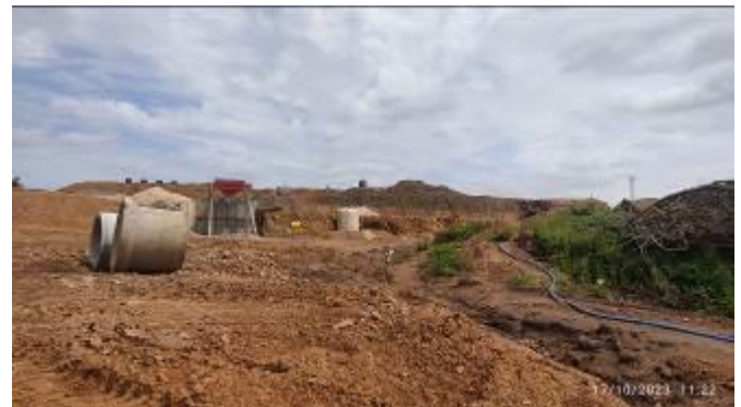
Foto 12.2-1 Riesgo de erosión de materiales hacia el cauce del Ao. Cuñapirú.
