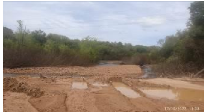
Foto 12.1-1 Falta completar recuperación ambiental de material de ataguía arrastrado por la corriente.
