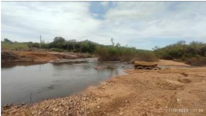
Foto 12.1-1 Falta completar recuperación ambiental de material de ataguía arrastrado por la corriente.
