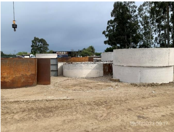
Foto 12.1-3. P02. Sector de acopio de encofrados perdidos
