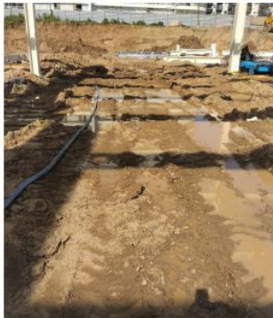
Situación previa y posterior a separación con geotextil para permitir acceso a obra, Montevideo
