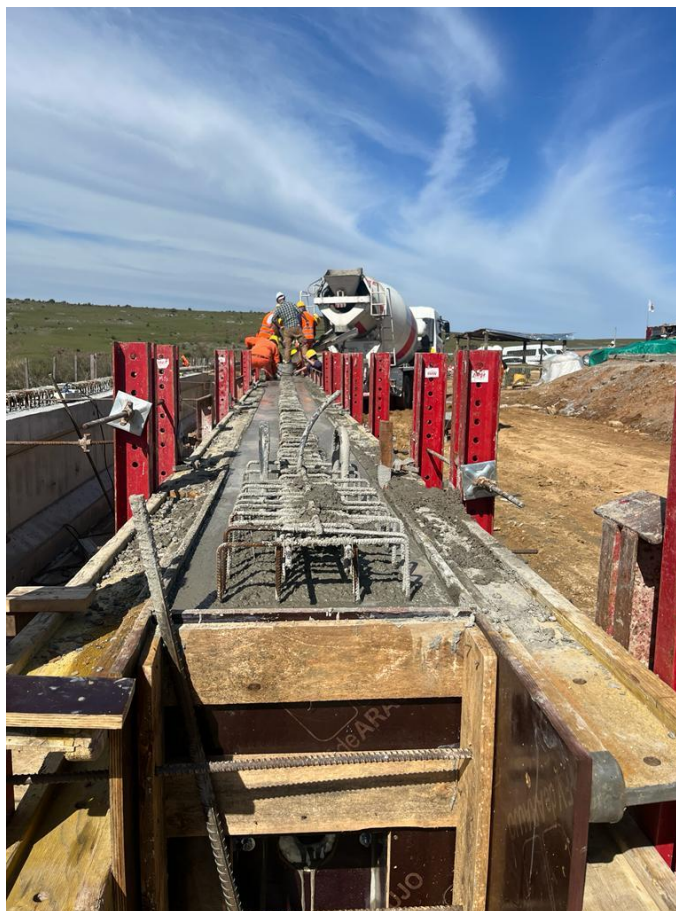
Ilustración 3: Hormigonado de vigas longitudinales.
