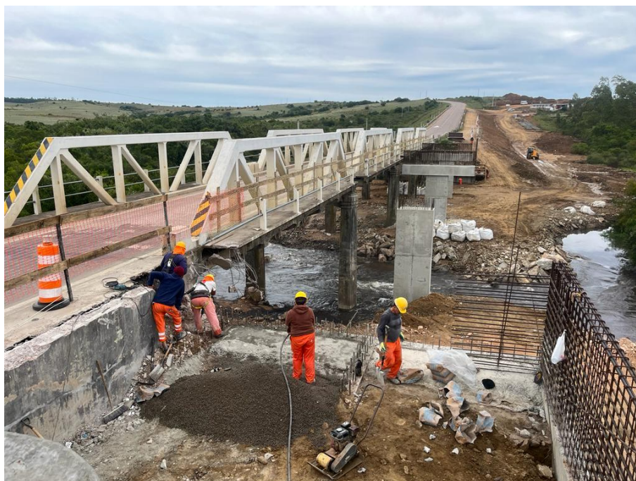
Ilustración 9: Demolición de baranda y pasarela peatonal.
