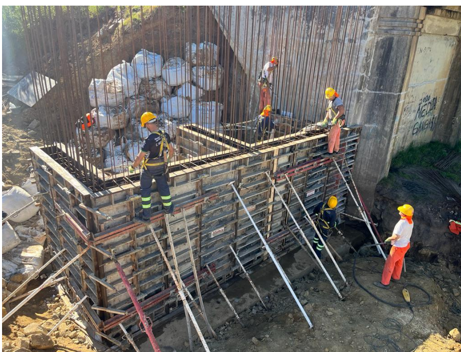
Ilustración 5: Hormigonado de estribo 5, primera etapa.
