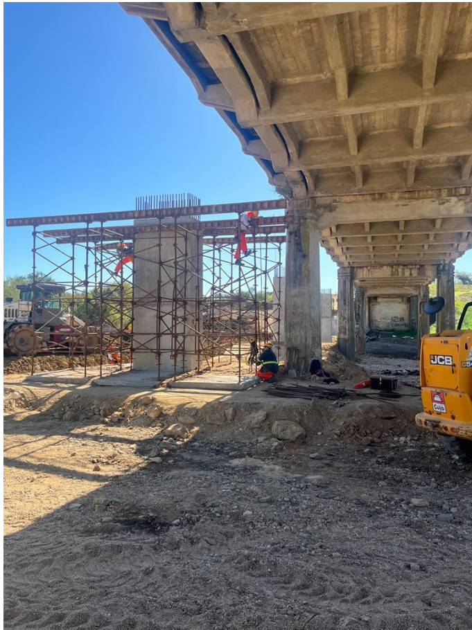
Ilustración 7: Encofrado de dintel, pórtico 2
