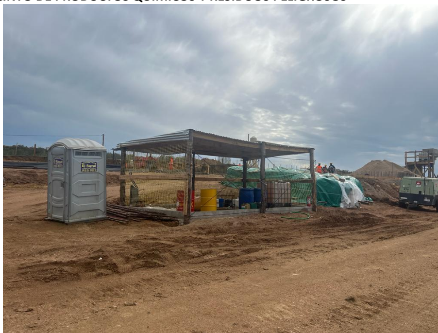
Imagen N°11 Recinto de productos químicos y residuos peligrosos.
