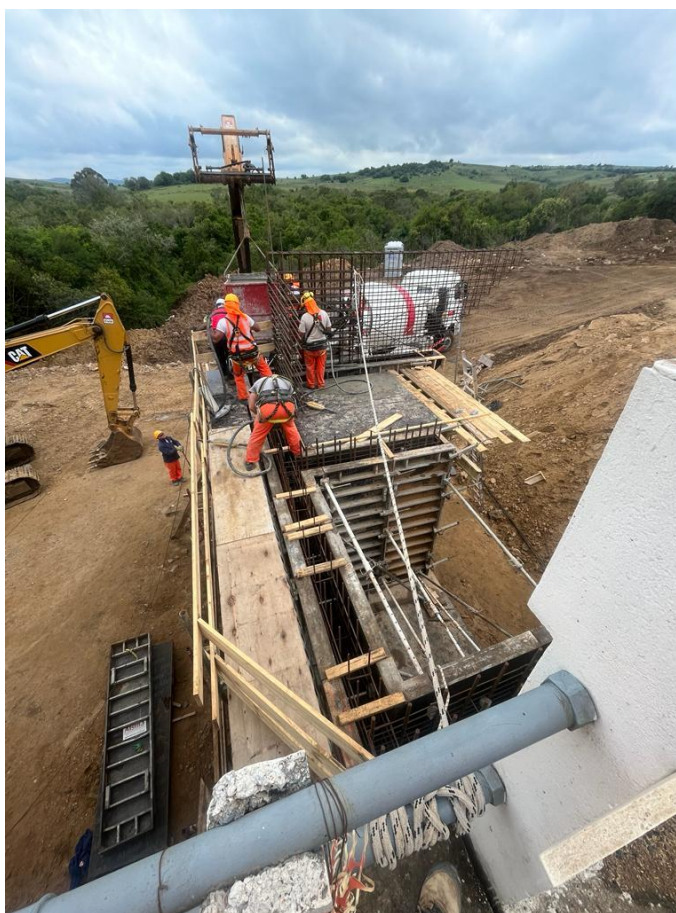
Ilustración 6: Hormigonado de estribo 5, segunda etapa.
