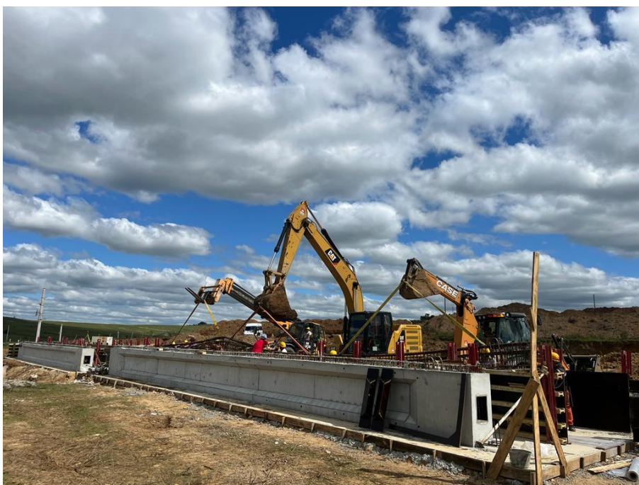
Ilustración 4: Desencofrado de vigas longitudinales.
