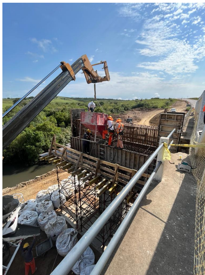
Ilustración 8: Hormigonado de dintel, pórtico 3.
