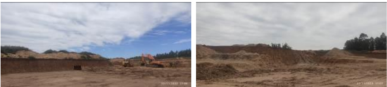
Foto 12.9-1 Vistas Cantera P 9249.
