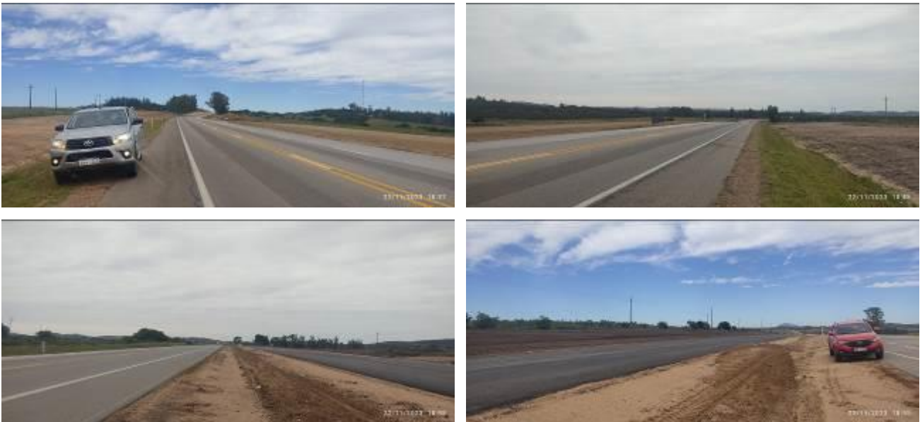
Foto 12.8-1 Vistas tramo de obra Colier.
