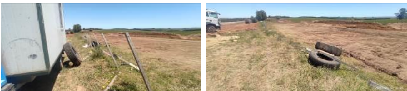
Foto 12.5-1 Cámaras sin cubrir en Cantera P 14248.
