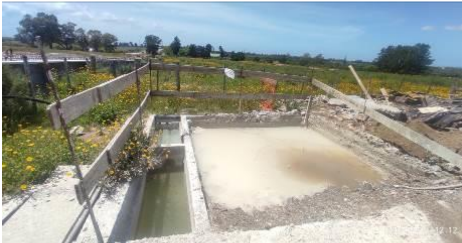
Foto 12.1-1 Derrames en Pileta de Hormigón.
