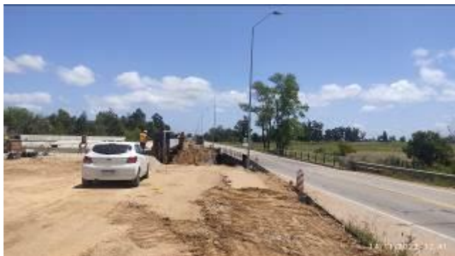
Foto 12.16-1 Puente Cañada Las Pajas.
