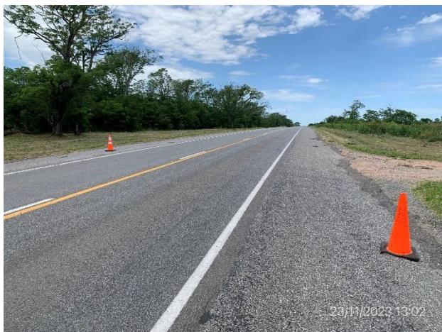
Foto 12.1-1, P03 . Frente de obras, Ruta 3 progresiva 331K600
