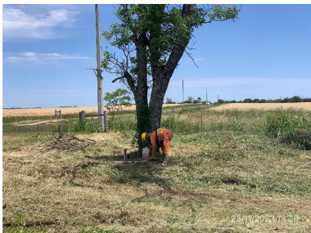
Foto 12.1-5, P03. Bidón de combustible apoyado sobre suelo desnudo, sin elementos de contención de derrames.
