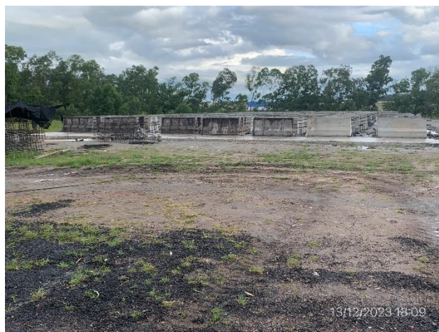
Foto 12.1-26, P03. Obrador. Plataforma de elaboración de vigas New – Jersey prefabricadas.
