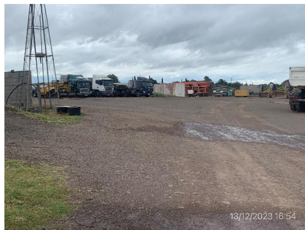
Foto 12.1-8, P04. Planta Asfáltica, explanada de maniobras.
