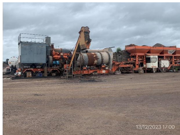
Foto 12.1-10, P04. Planta Asfáltica, sin actividad el día de la auditoría.
