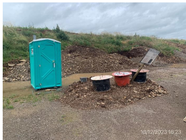
Foto 12.1-2, P05. Cantera, sector de acopio temporal de residuos segregados por corriente de generación.
