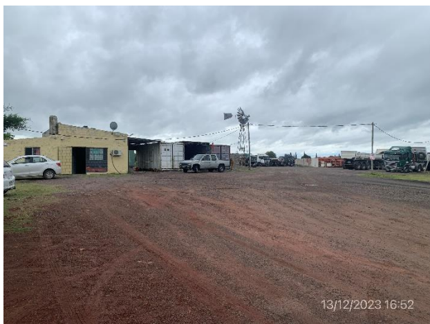
Foto 12.1-7, P04. Planta Asfáltica, Ruta 5 progresiva 220K000 a (-). Padrón 10207, 3ª SC de Durazno.
