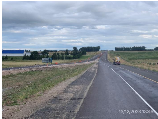
Foto 12.2-2. Tramo de calzada de segunda vía terminado, con señalización horizontal provisoria.
