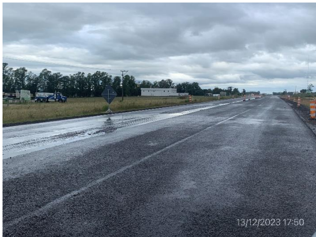
Foto 12.2-1. Tramo de obra terminado, Ruta 5 progresiva 175K500. Pendientes en banquetas adecuadas
