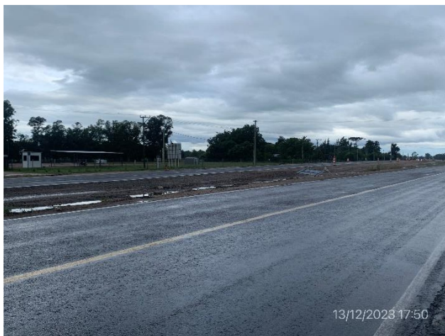
Foto 12.2-3. Tramo de calzada de segunda vía terminado, con señalización horizontal provisoria.
