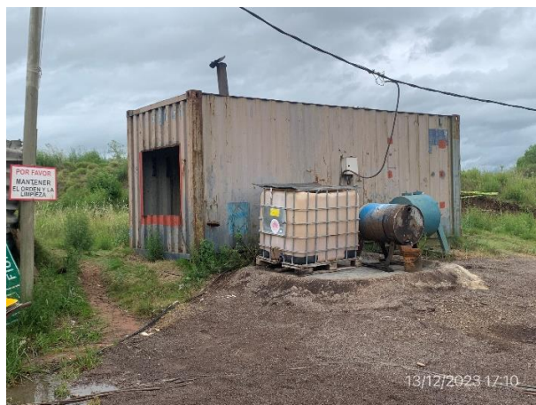
Foto 12.1-12, P04. Planta Asfáltica, generador eléctrico. Envallado perimetral en condiciones correctas.
