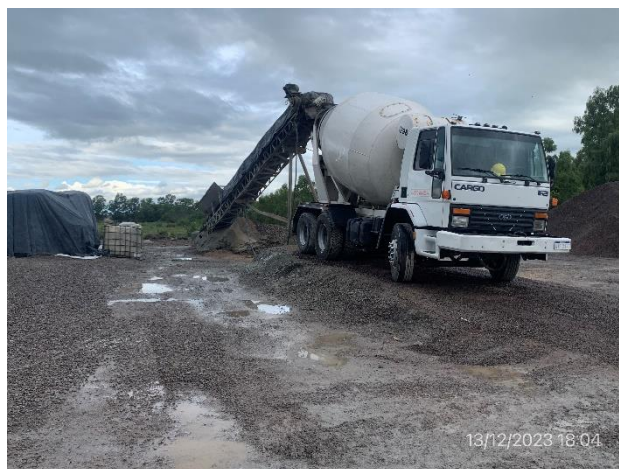
Foto 12.1-24, P03. Obrador, planta de hormigón. Buenas condiciones de limpieza sin presencia de ROCs o restos de cemento portland.
