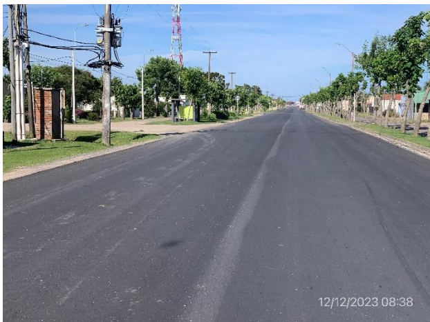
Foto 12.2-3. Recapado terminado en Ruta 23, planta urbana de Ismael Cortinas.
