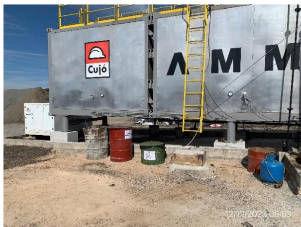
Foto 12.1-10, P03. Planta asfáltica, zona limpia de derrames e infraestructura adecuada para acopio transitorio de residuos.
