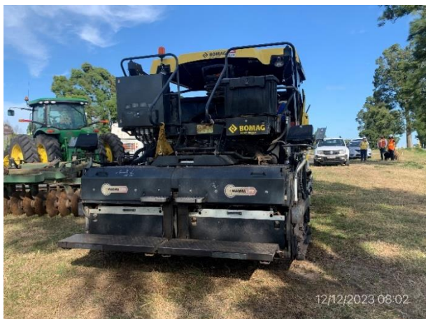
Foto 12.2-9, P05. Estacionamiento de maquinaria en Ruta 23, progresiva 121K700 a (-).
