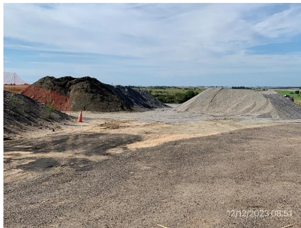
Foto 12.1-2, P03. Obrador, zona de acopio de áridos y explanada de maniobras.
