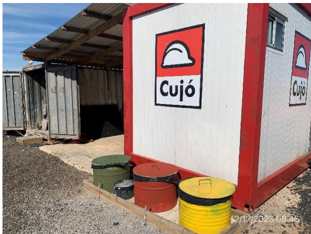
Foto 12.1-3, P03. Obrador, estación de acopio transitorio de residuos segregados por corriente de generación.
