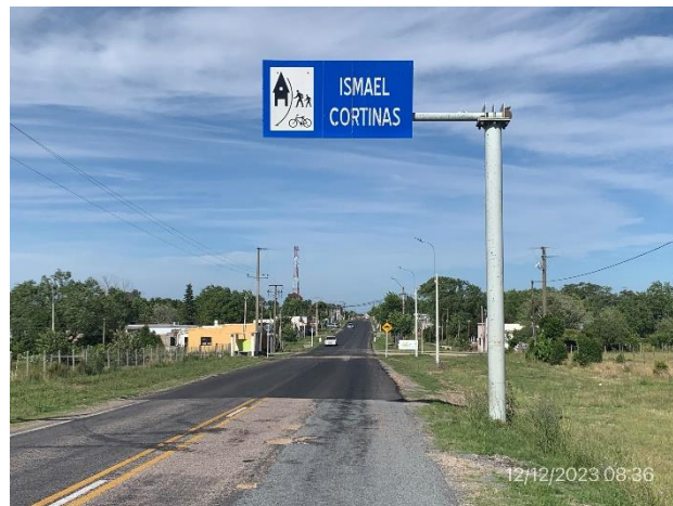
Foto 12.2-4, P02. Fin de obras en Ruta 23, progresiva 152K200, acceso Este a Ismael Cortinas.
