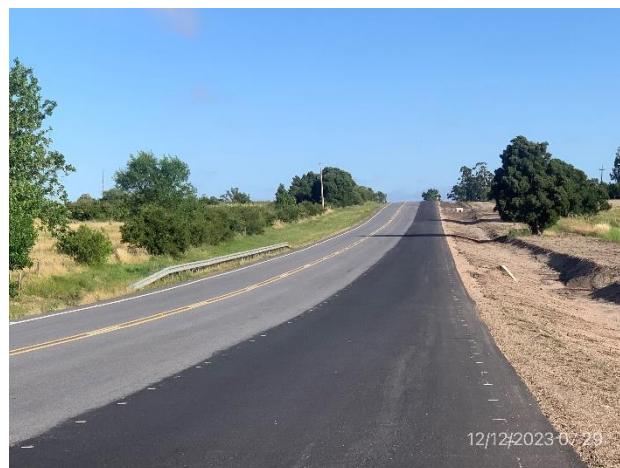
Foto 12.2-6. Ruta 23, terceras vías con carpeta asfáltica ejecutada.
