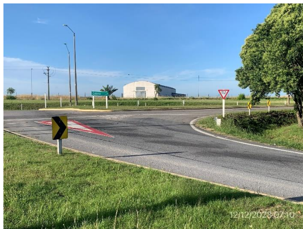
Foto 12.2-2, P01. Inicio de obra, Ruta 23, progresiva 100K000, empalme con Ruta 11.
