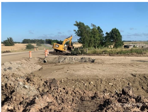
Foto 12.2-7, P04. Frente de obras de ensanche de plataforma en Ruta 23, progresiva 118K600 a (+).
