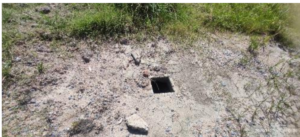
Foto 12.2-1 Cámara sin tapa.
