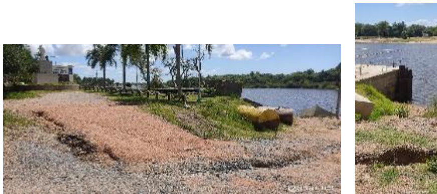
Foto 12.1-3 Vistas acceso Oeste al puente.
