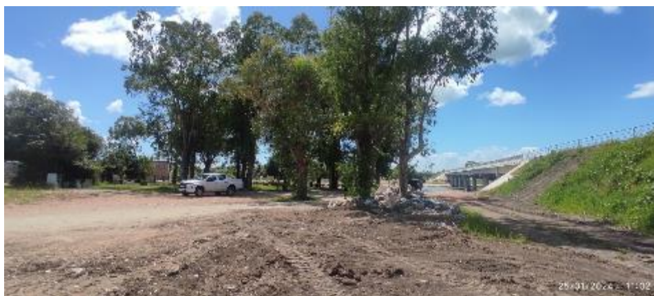
Foto 12.5-2 Vista Puente acceso Oeste.
