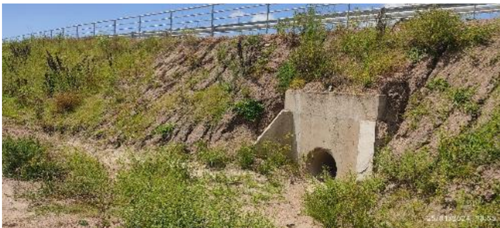
Foto 12.1-1 Vta. 1, acceso Oeste
