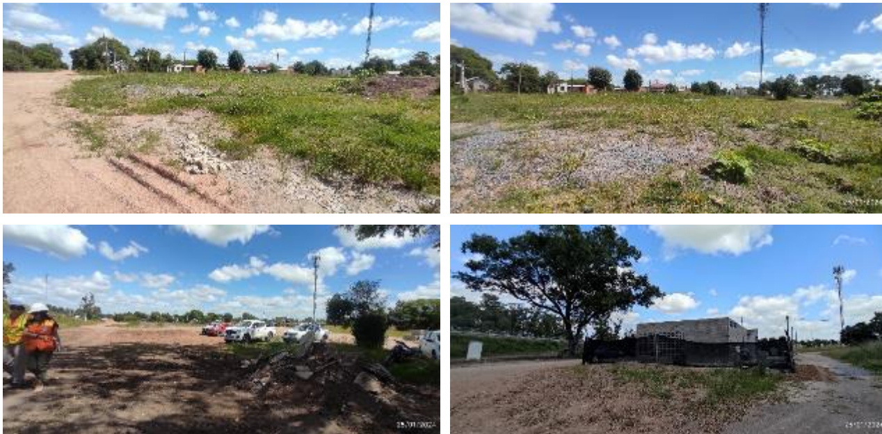
Foto 12.6-1 Vistas predio obrador.
