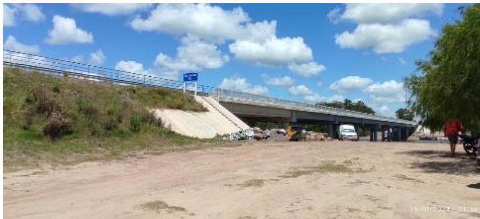
Foto 12.5-1 Vista Puente acceso Este.
