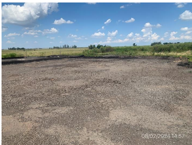
Foto 12.1-5, P03. Estacionamiento de cisternas, quedan eventualmente como mejora a beneficio del propietario.
