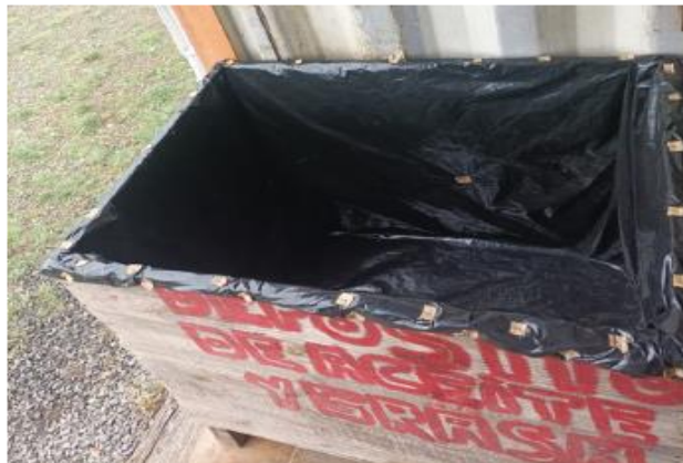
Foto 12.3-2, P03. Depósito impermeabilizado para alojar bidones de combustible.
