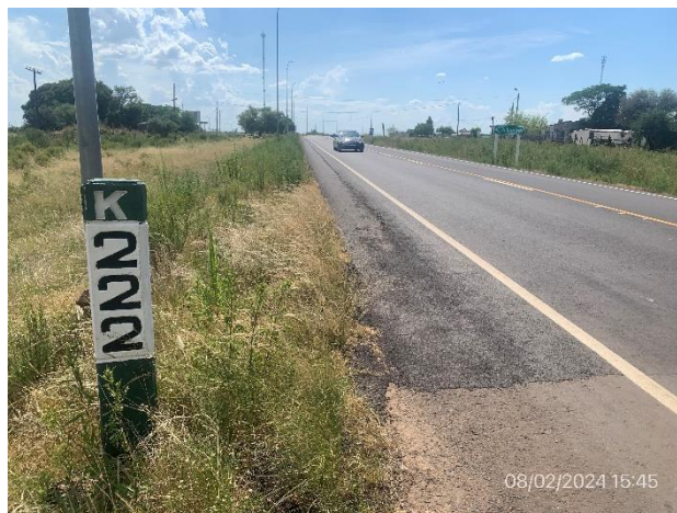
Foto 12.2-2, P01. Inicio de tramo. Ruta 30 progresiva 222K000.
