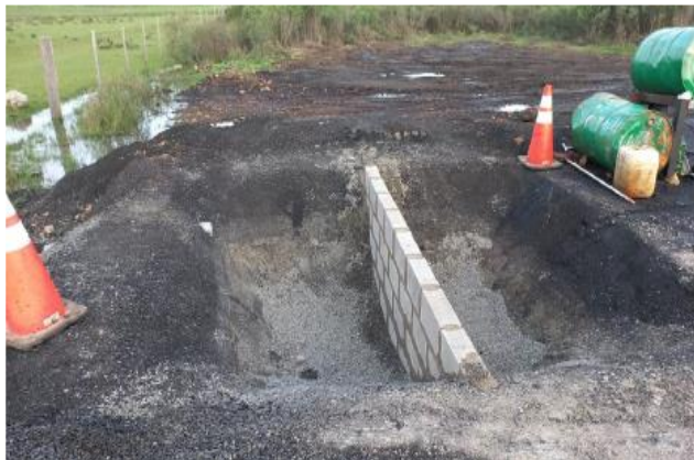
Foto 12.3-1, P03. Reservorio impermeable con batea de decantación en construcción para contención de aguas de lavado de camiones.
