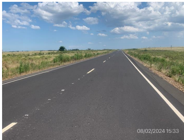
Foto 12.2-4, Ruta 30. Recapado en mezcla asfáltica terminado, con señalización concluida.
