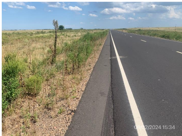
Foto 12.2-3, Ruta 30. Faja pública en buenas condiciones de limpieza, sin ROCs visibles.
