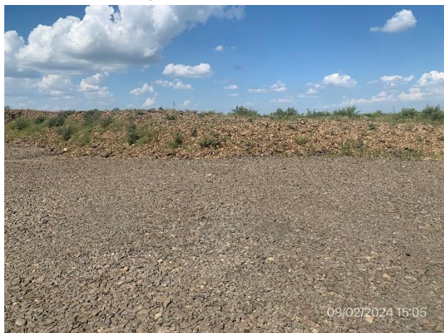
Foto 12.1-8, P04. Frente de cantera con abatimiento de pendientes por medio de material de destape estéril.
