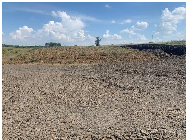
Foto 12.1-9, P04. Frente de cantera con abatimiento de pendientes por medio de material de destape estéril..
