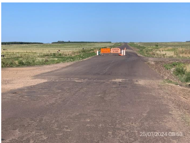
Foto 12.2-5, P01. Inicio de tramo. Ruta 20 progresiva 138K500.
