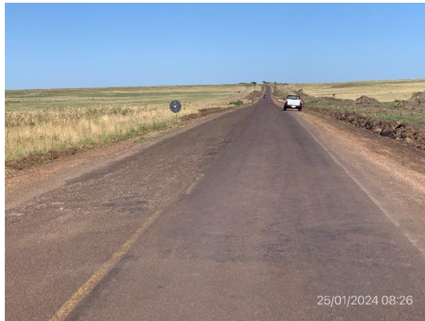
Foto 12.2-2, Ruta 20. Tramo con trabajos de bacheo en ejecución.
