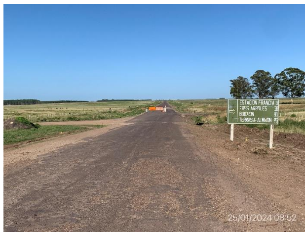
Foto 12.2-6, P01. Inicio de tramo. Ruta 20 progresiva 138K500.
