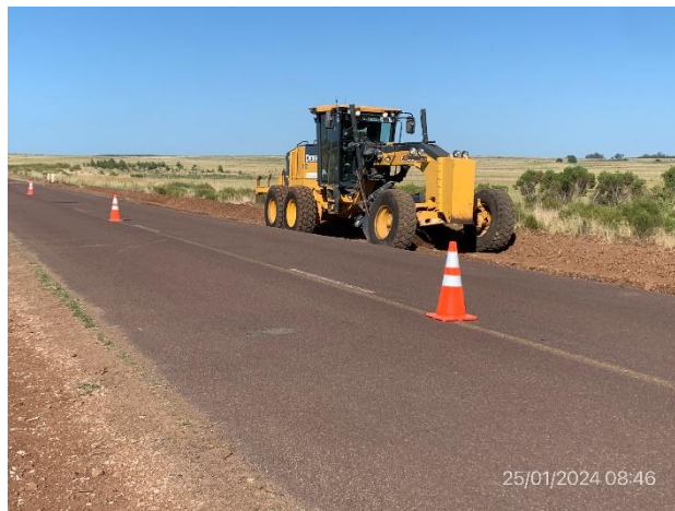
Foto 12.2-4, P05. Frente de obra. Ruta 20 progresiva 144K900.
