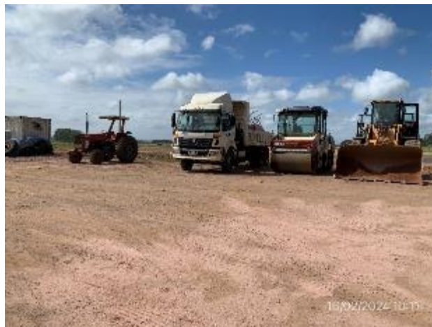
Foto 12.1-2, P03. Obrador, explanada de maniobras y en condiciones apropiadas de orden y limpieza.
