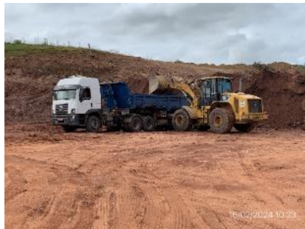
Foto 12.1-12, P04. Cantera de balasto y tosca. Explotación de yacimiento de tosca en proceso.
