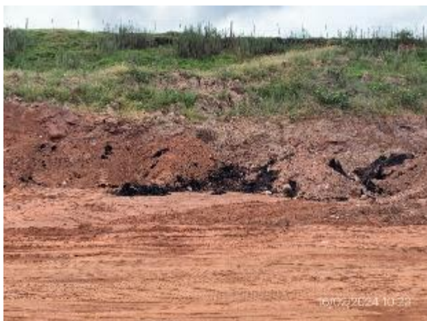
Foto 12.1-13, P04. Cantera de balasto y tosca. Alije de mezcla asfáltica sin correcta disposición transitoria
