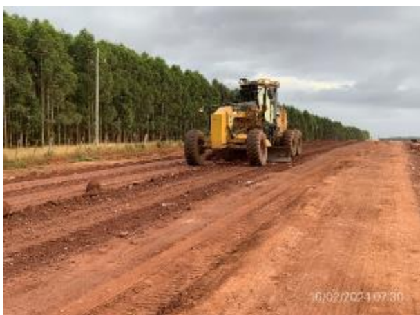
Foto 12.2-5, P09. Frente de obras de ensanche de plataforma. Ruta 6 progresiva 280K200.
