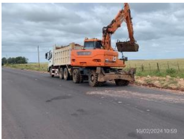
Foto 12.2-3, P10. Frente de obras de terminación de alcantarillas, Ruta 6 progresiva 242K500 a (-).
