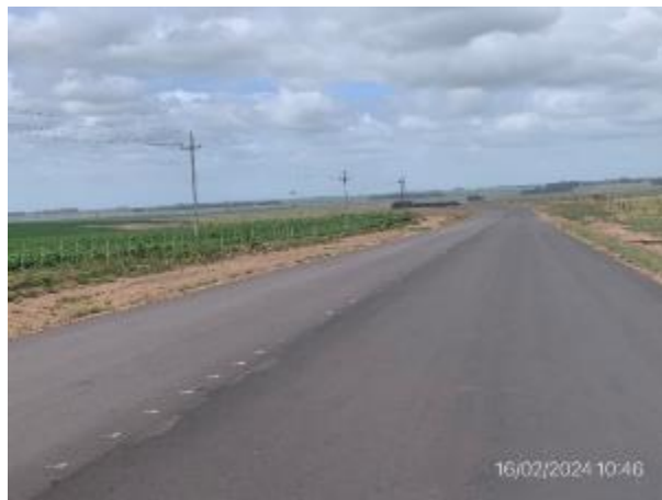
Foto 12.2-2, Ruta 6. Tramo con carpeta asfáltica terminada.
