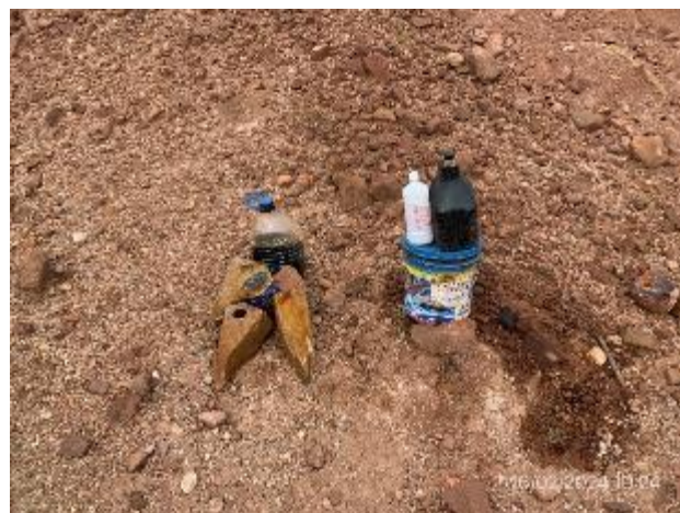
Foto 12.1-14, P04. Cantera de balasto y tosca. No hay infraestructura prevista para acopio temporal de residuos, hay residuos dispersos y lubricantes incorrectamente almacenados.
