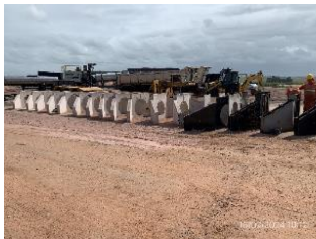
Foto 12.1-10, P03. Obrador, zona de prefabricados de hormigón.
