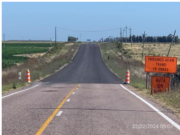
Foto 12.2-1, P01. Inicio de tramo. Ruta 23, progresiva 161K000.
