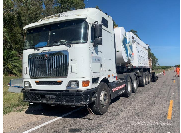
Foto 12.2-8, P05. Frente de obras. Carpeta de rodadura en Cape Seal en ejecución.
