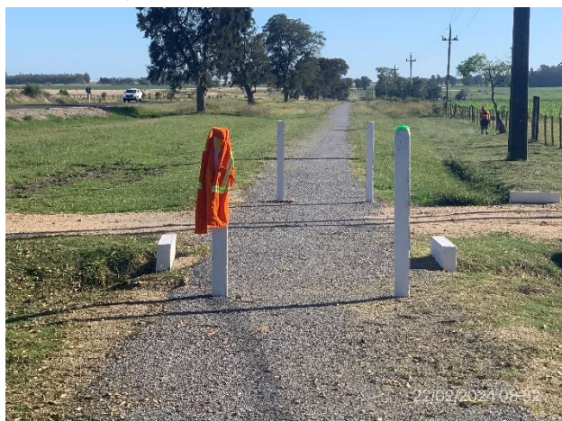
Foto 12.2-5, Ruta 23. Tramo de bicisenda secundaria en tratamiento bituminoso ejecutada.
