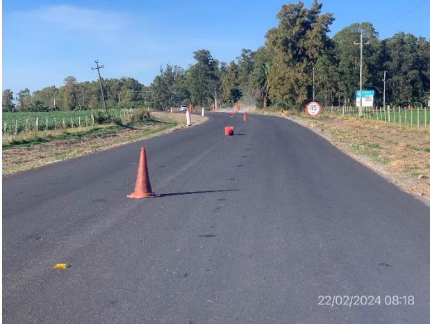
Foto 12.2-7, P05. Frente de obras. Empalme con Cno. del Abuelo, Ruta 3 progresiva 194K400 a (-).
