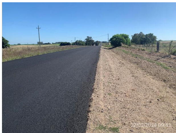
Foto 12.2-6, Ruta 23. Cuneta con drenajes suaves y empastado incipiente.
