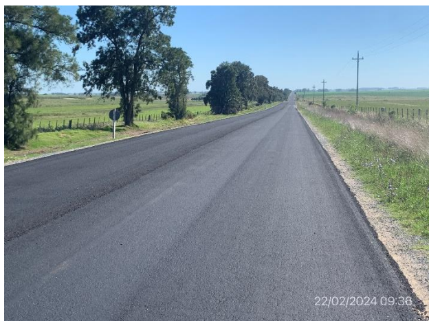
Foto 12.2-3, Ruta 23. Carpeta en Cape Seal terminada, con faja pública y drenajes concluidos en buenas condiciones
