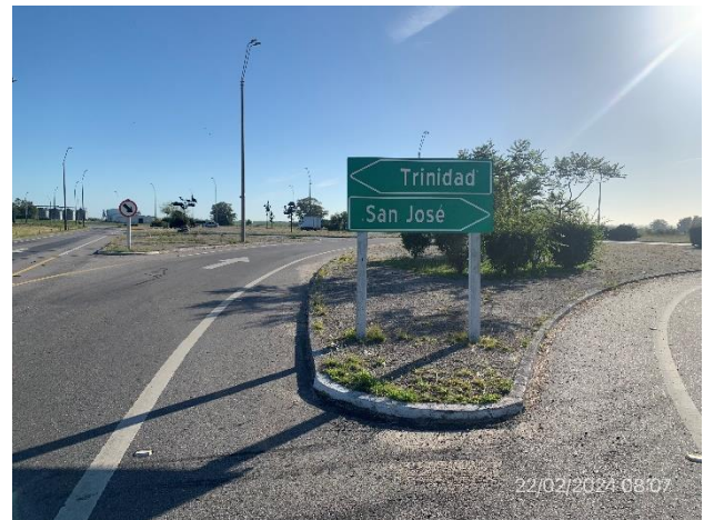
Foto 12.2-10, P02. Fin de tramo. Ruta 23, empalme con Ruta 3.
