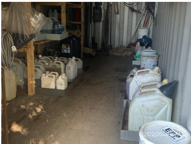
Foto 12.1-3, P03. Obrador. Acopio de lubricantes en local techado.
