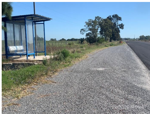
Foto 12.2-4, Ruta 23. Dársena para ómnibus terminada.
