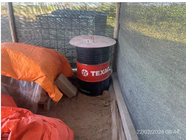
Foto 12.1-5, P03. Residuos peligrosos en recinto techado y con pavimento impermeable envallado.
