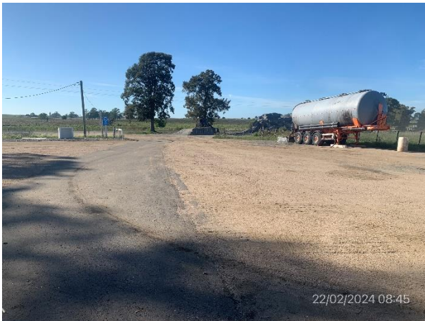
Foto 12.1-1, P03. Obrador de Serviam SA. Ruta 23, progresiva 183K300 a (-).
