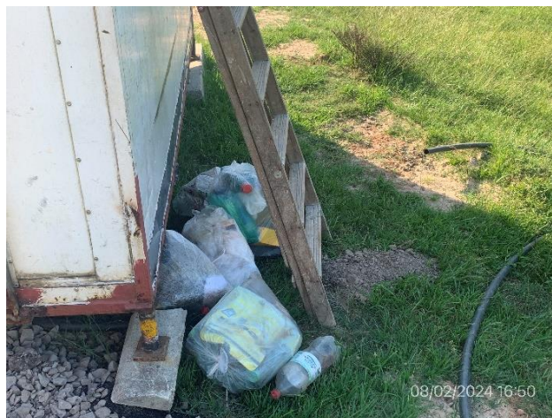
Foto 12.3-2, P09. Residuos mezclados, acopio temporal en condiciones inadecuadas.
