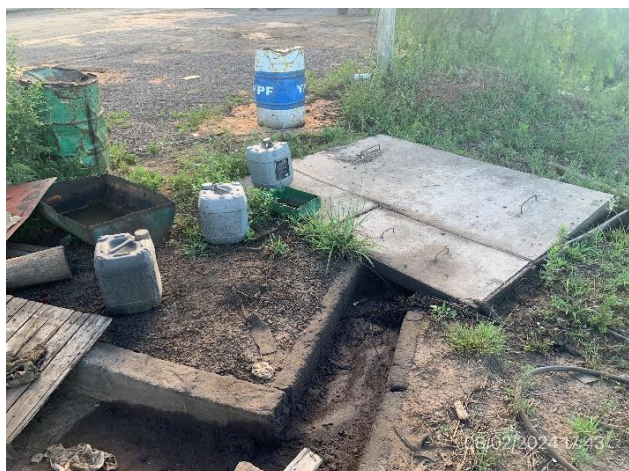
Foto 12.1-7, P05. Punto de evacuación de aguas de lavado. No se evidencia que haya separación efectiva de arenas contaminadas. Hay tarrinas de lubricantes apoyadas sobre suelo desnudo.
