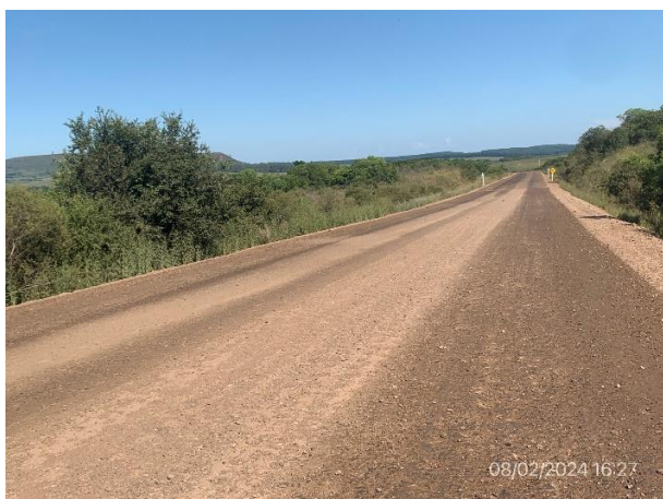
Foto 12.2-5, Ruta 30. Tramo de base granular reciclada y cementada.
