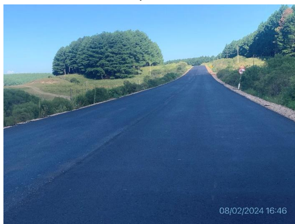
Foto 12.2-6, Ruta 30. Tramo con nueva carpeta asfáltica ejecutada.
