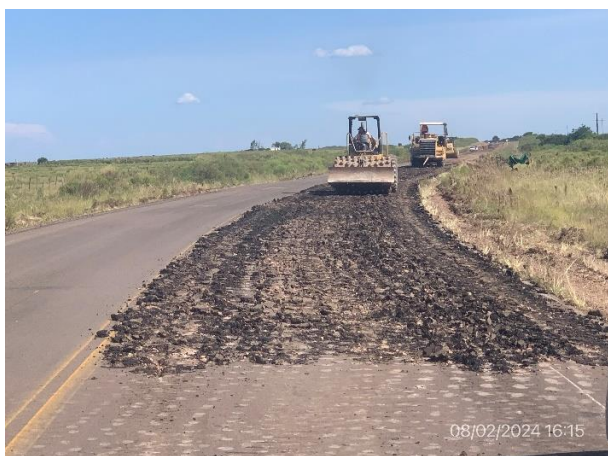
Foto 12.2-3, P06. Frente de obras, Ruta 30 progresiva 231K500.
