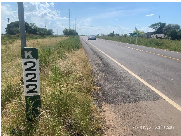
Foto 12.2-1, P04. Fin de tramo, Ruta 30 progresiva 222K000, acceso a Masoller, Rivera.
