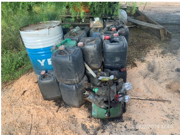
Foto 12.1-9, P05. Tarrinas de lubricantes apoyadas en suelo desnudo con un envallado precario.
