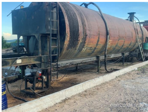
Foto 12.1-4, P05. Planta asfáltica. No hay estación para acopio temporal de residuos.
