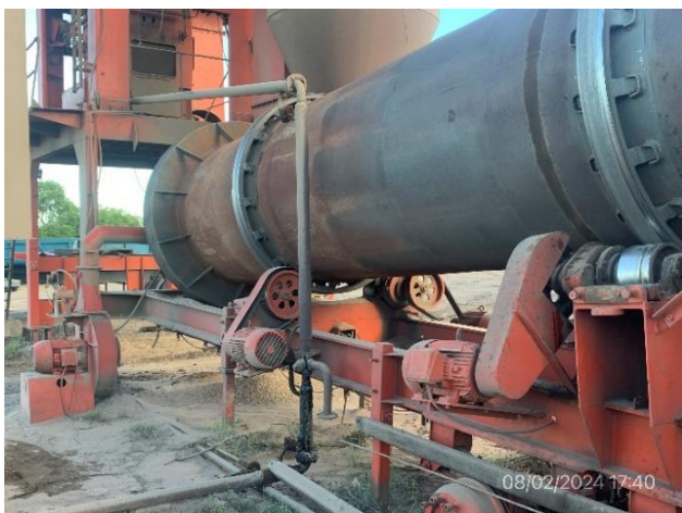
Foto 12.1-3, P05. Planta asfáltica, envallados adecuados y zona limpia.
