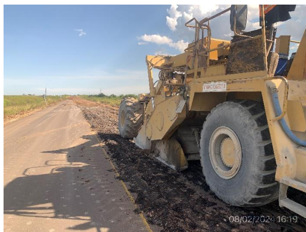
Foto 12.2-4, P06. Tareas de reciclado de carpeta existente en ejecución.
