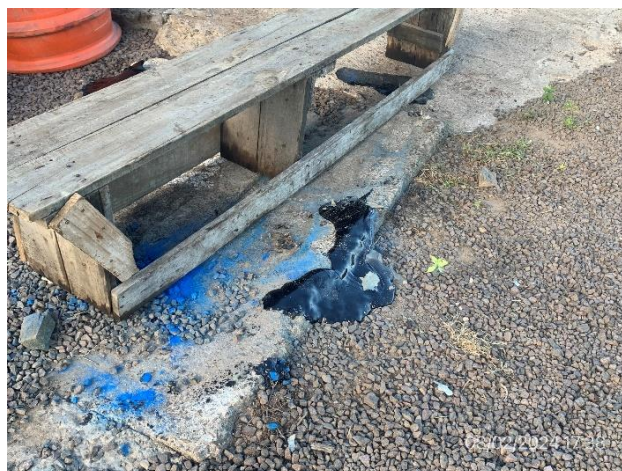
Foto 12.1-8, P05. Derrame de emulsión asfáltica sin disponer en sector apropiado.
