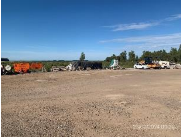
Foto 12.1-1, P05. Obrador y planta asfáltica de Meliter SA. Ruta 20, progresiva 123K600 a (-).
