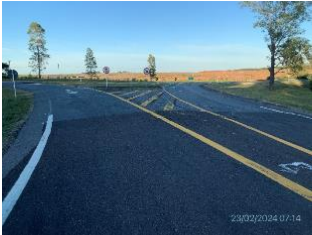
Foto 12.2-1, P01. Inicio de tramo. Ruta 20, progresiva 75K500. Empalme con Ruta 3.
