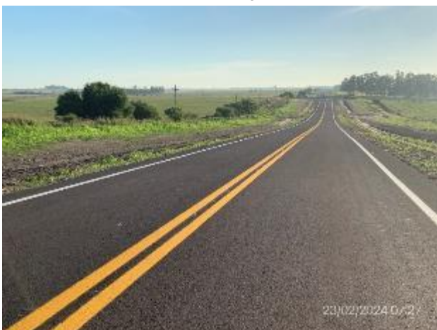
Foto 12.2-5, Ruta 20. Carpeta de rodadura en mezcla asfáltica con señalización horizontal ejecutada .
