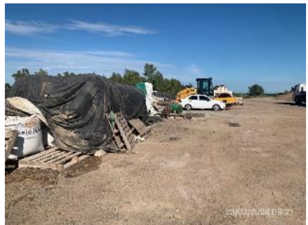
Foto 12.1-6, P05. Obrador, segunda explanada de acopio y estacionamiento extendida hacia camino vecinal.
