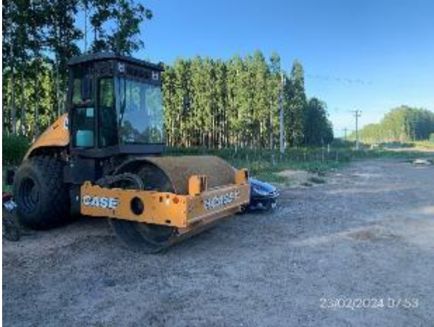
Foto 12.2-7, P03. Obrador secundario con desmontaje en proceso. Faja pública de nueva traza de Ruta 20, progresiva 111K200 a (+).
