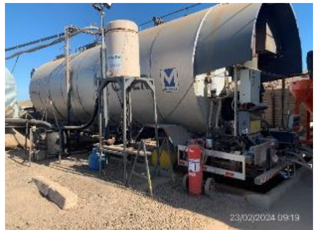
Foto 12.1-4, P05. Planta asfáltica. Envolvado perimetral correcto.
