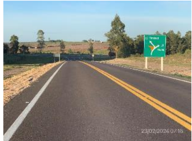
Foto 12.2-2, P01. Inicio de tramo. Ruta 20, progresiva 75K500. Empalme con Ruta 3.
