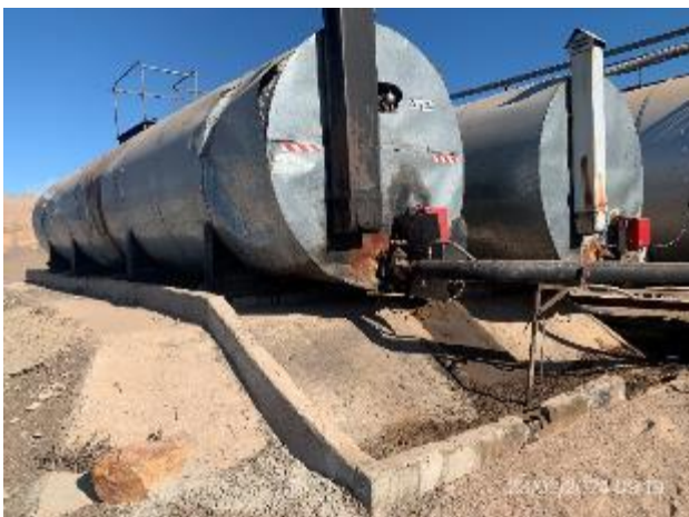
Foto 12.1-5, P05. Planta asfáltica, cisternas fijas elevadas con envolvado perimetral correcto.
