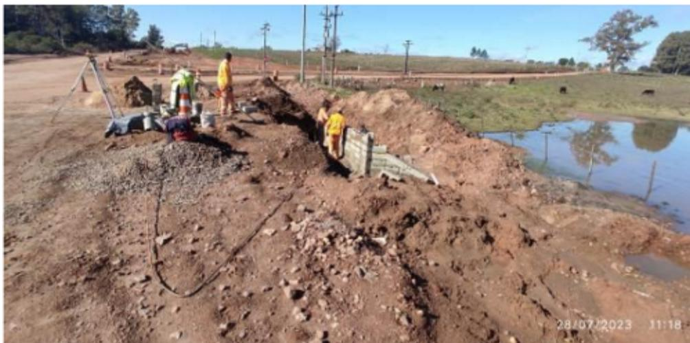
Foto 12.1-1 Falta de contención para lavado de herramientas con hormigón.
