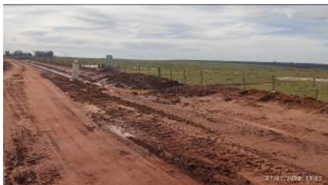
Foto 11.2-2 Canalización de pluviales a predios vecinos.
