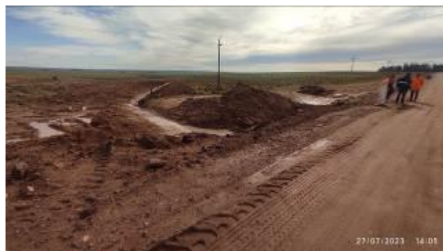
Foto 11.2-2 Canalización de pluviales a predios vecinos.
