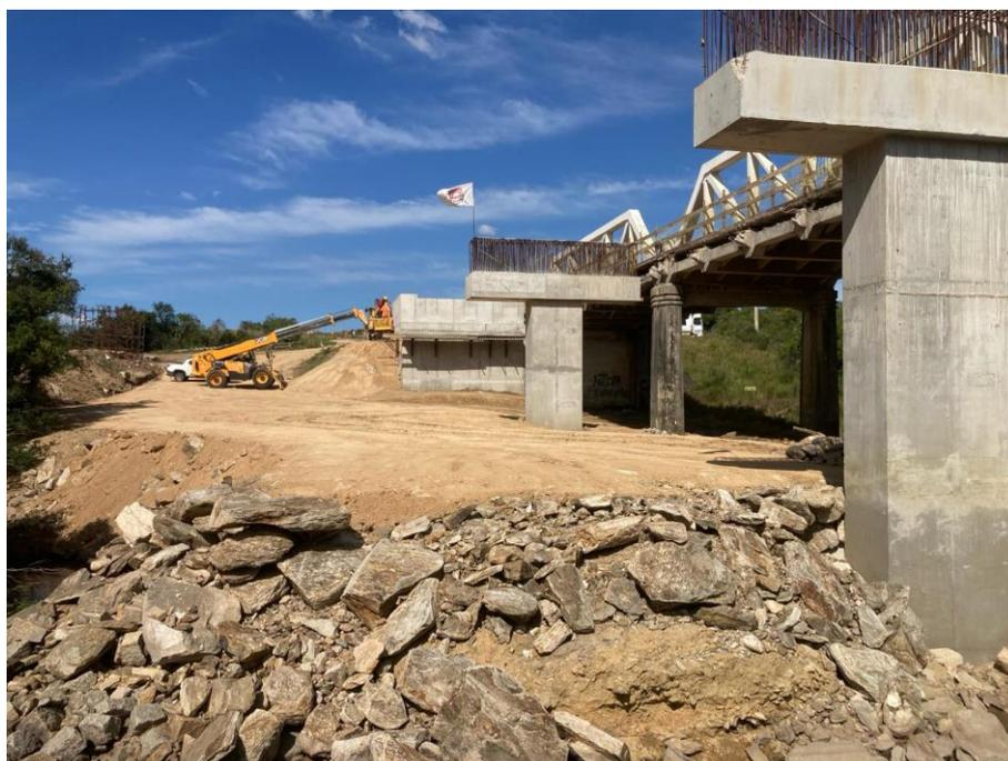
Ilustración 7: Desencofrados de dinteles pórticos.
