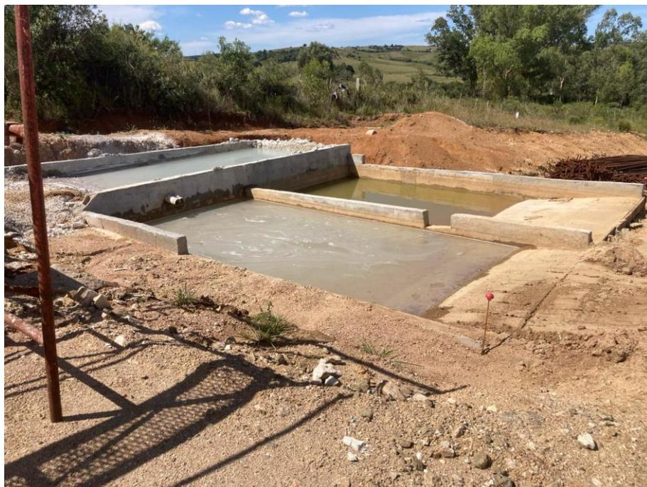
*Ilustración 5: Piletas de lavado de mixers.*
