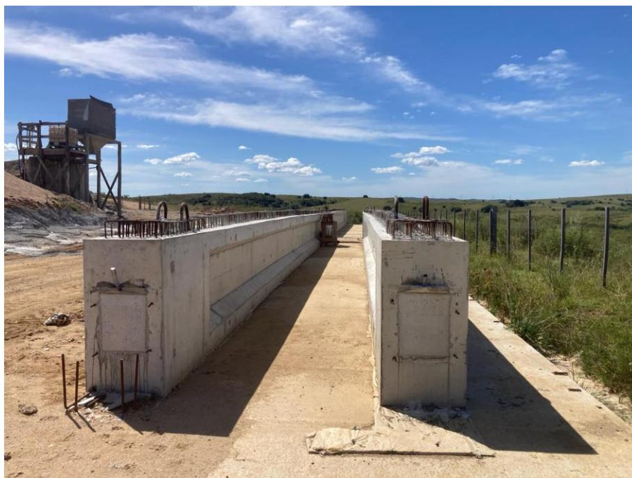
Ilustración 6: Vigas longitudinales de hormigón.
