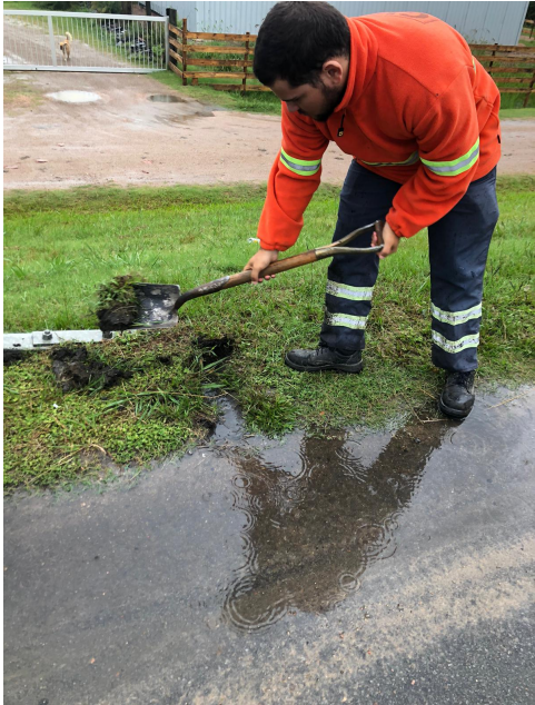
Imagen 2 - Limpieza de pluviales
