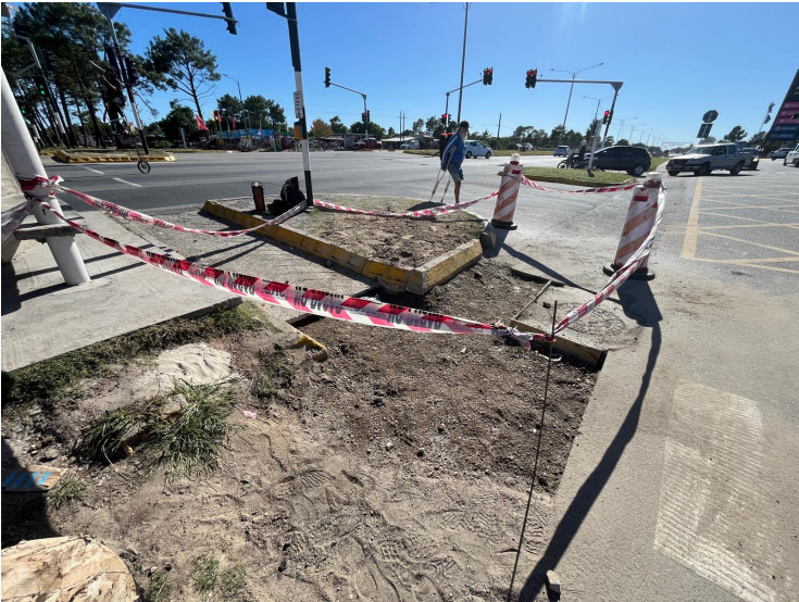
Imagen 7 - Trabajos en Pinamar
