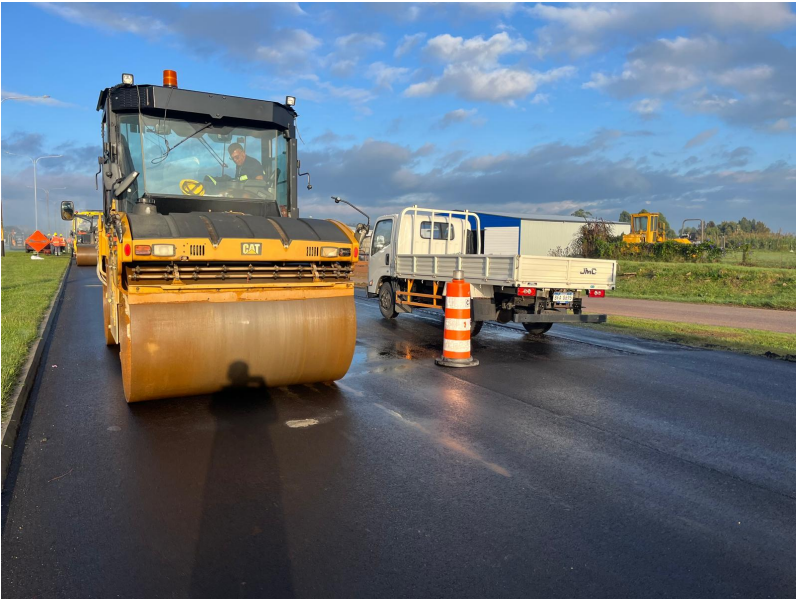
Imagen 10 - Tendido de asfalto
