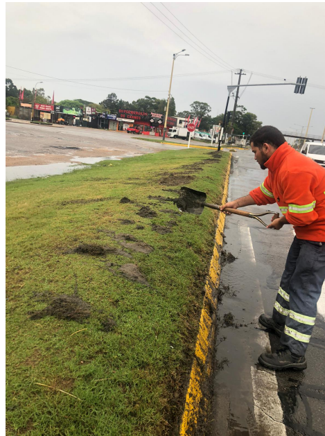
Imagen 1 - Limpieza de pluviales
