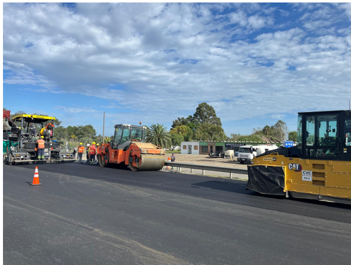
Imagen 11 - Tendido de asfalto
