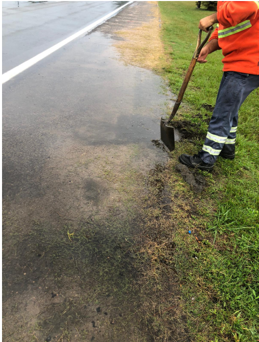
Imagen 3 - Limpieza de pluviales
