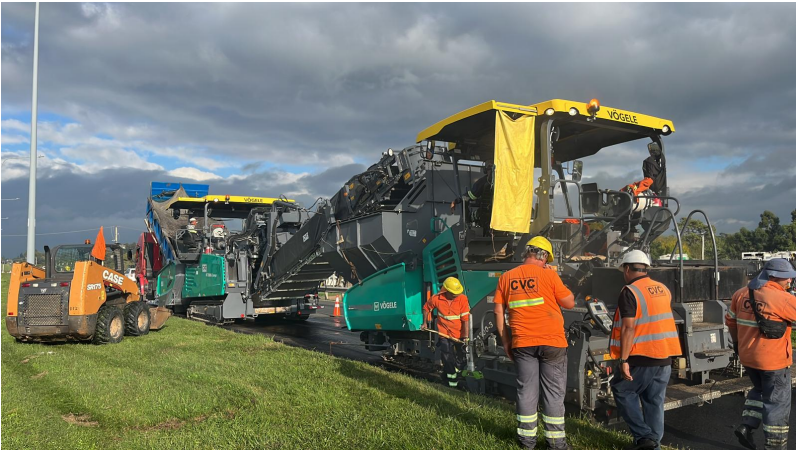
Imagen 9 - Tendido de asfalto
