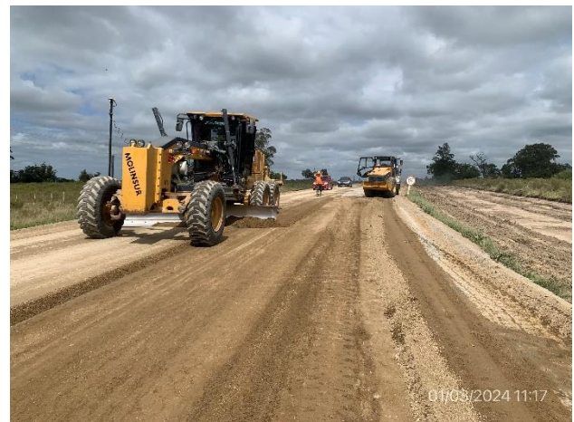
Foto 12.2-4, P06. Frente de obras, reciclado de base granular. Ruta 63 progresiva 14K100.
