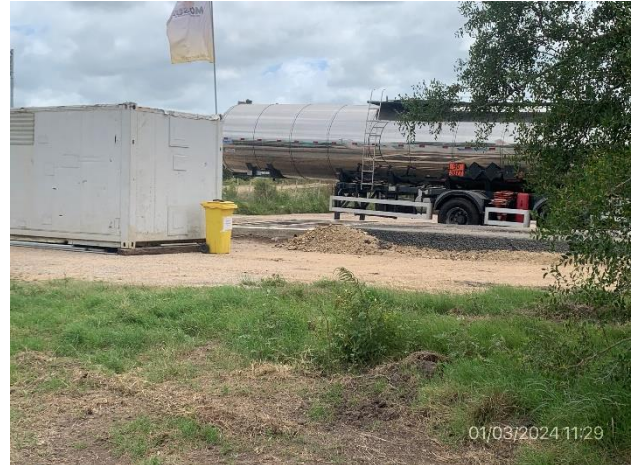
Foto 12.1-2, P04. Escasa infraestructura para acopio temporal de residuos segregados por origen.
