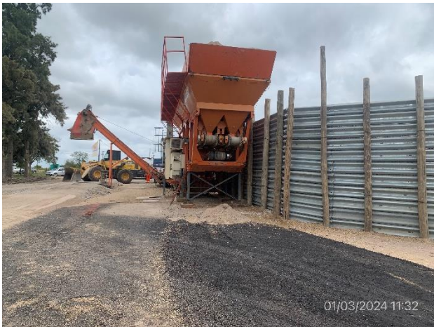
Foto 12.1-3, P04. Planta asfáltica en proceso de ensamble.
