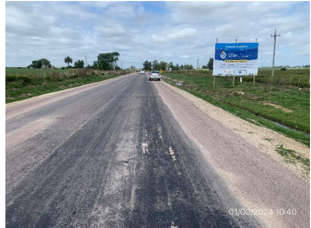
Foto 12.2-2, P01. Ruta 63, base granular cementada con imprimación terminada.
