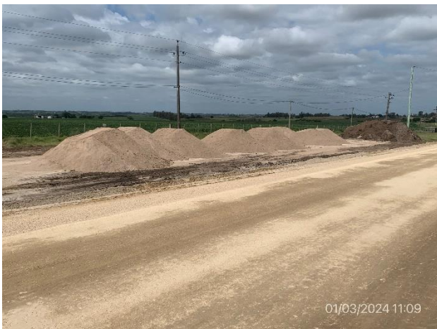
Foto 12.2-3, Ruta 63. Base granular cementada.
