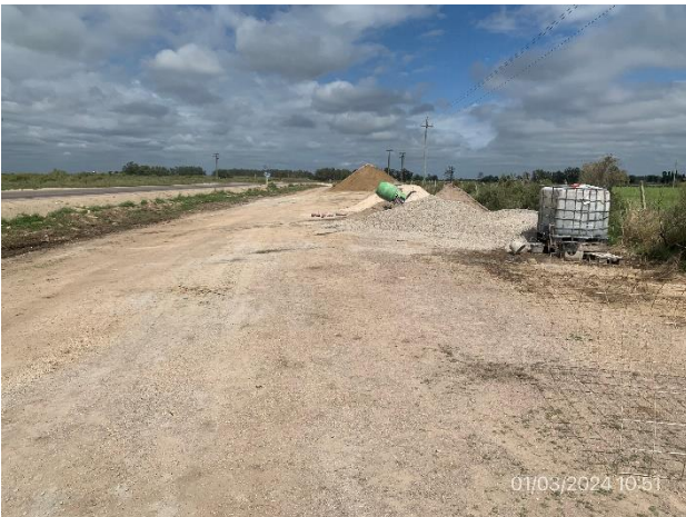
Foto 12.2-9, P07. Campamento en faja pública de Ruta 63, progresiva 2K600 a (+).
