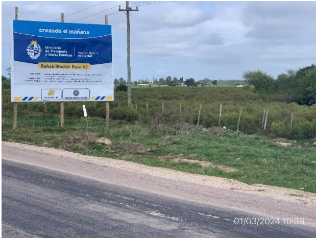
Foto 12.2-1, P01. Inicio de tramo. Ruta 63 progresiva 0K700, acceso Oeste a San Ramón, Canelones.
