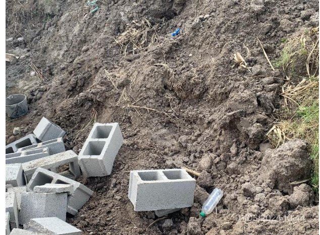
Foto 12.2-8, P05. Frente de obras, residuos dispersos al no haber infraestructura para acopio temporal de residuos.
