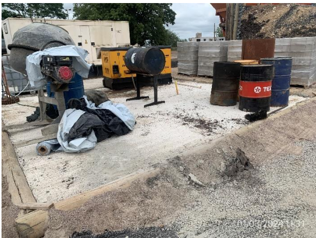
Foto 12.1-5, P04. Planta asfáltica, construcción de zona de acopio de tarrinas con hidrocarburos.
