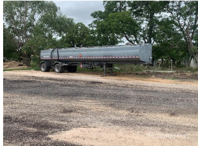
Foto 12.1-8, P04. Obrador, cisterna de emulsión estacionada en zona inapropiada al carecer de los elementos que previó el PGA para prevenir derrames.
