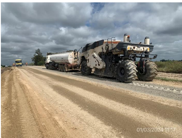
Foto 12.2-5, P06. Frente de obras, reciclado de base granular. Ruta 63 progresiva 14K100.
