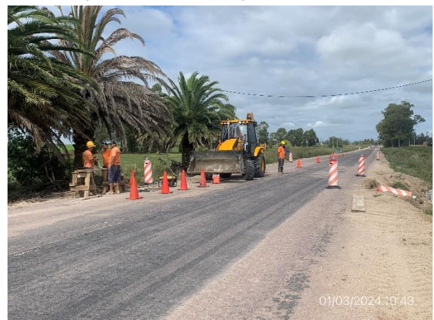
Foto 12.2-6, P05. Frente de obras, alcantarilla en construcción. Ruta 63 progresiva 1K500.
