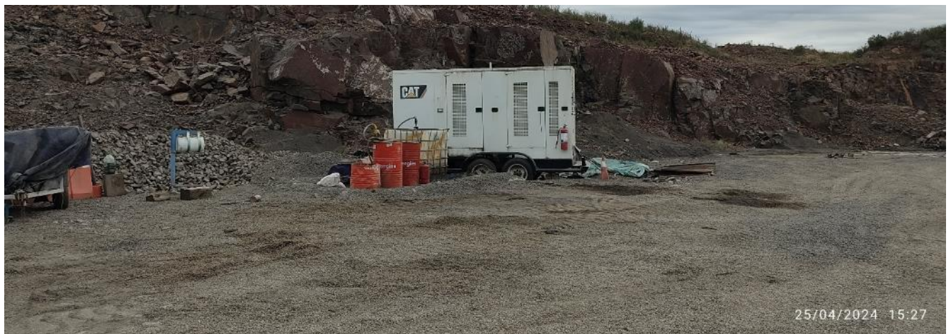
Foto 12.5-1 Vistas Cantera Padrón 1126 e instalaciones.
