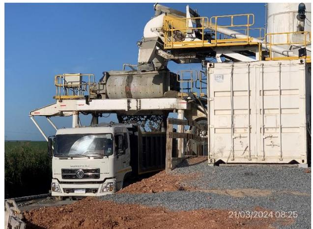
Foto 12.1-16, P04. Carga de cazamba con hormigón.
