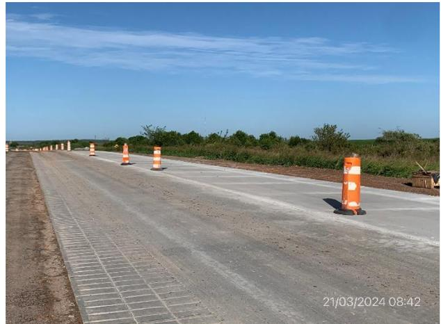
Foto 12.2-4. Ruta 20 con tramo parcialmente terminado, pavimento y banquetas de hormigón ejecutadas.
