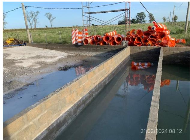
Foto 12.1-10, P04. Pileta de decantación de aguas de lavado de cazambas de hormigón.
