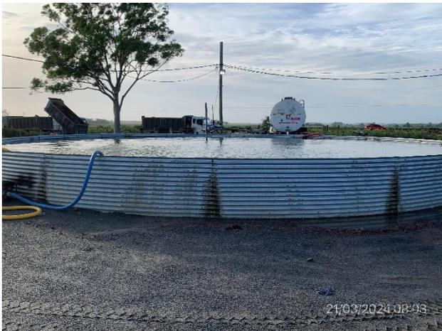
Foto 12.1-7, P04. Tanque australiano para recirculación de agua no potable.
