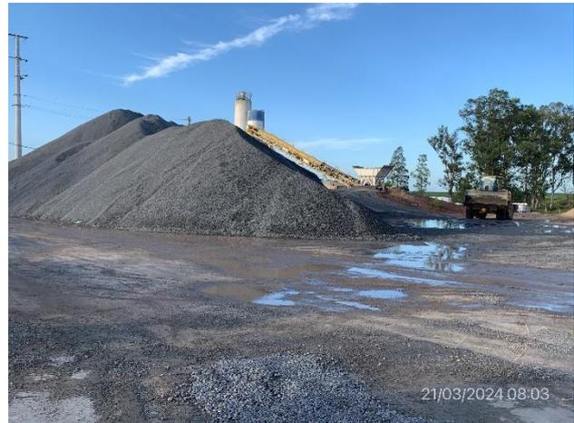
Foto 12.1-6, P04. Explanada de maniobras, estacionamiento y de acopio de áridos.
