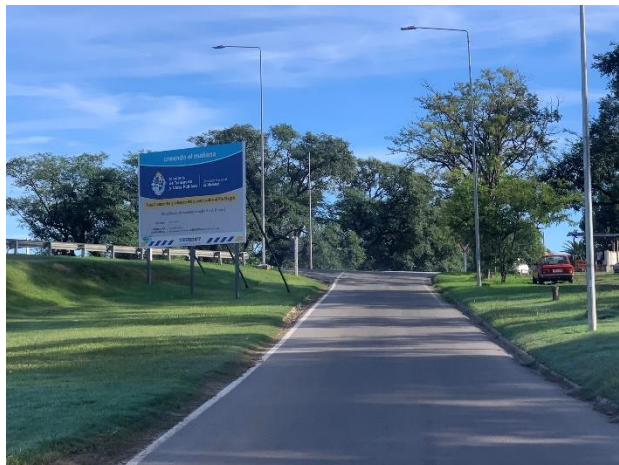
Foto 12.2-1, P01. Acceso a cabecera Sur del puente de Ruta 2 sobre el Río Negro.
