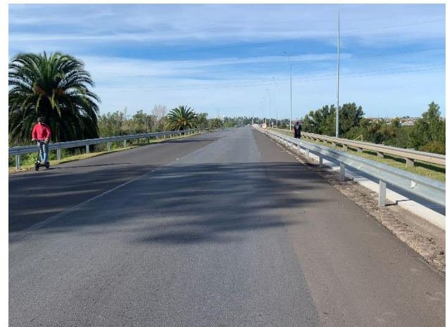
Foto 12.2-2, P01. Puente terminado de Ruta 2 sobre el Río Negro abierto al tránsito.
