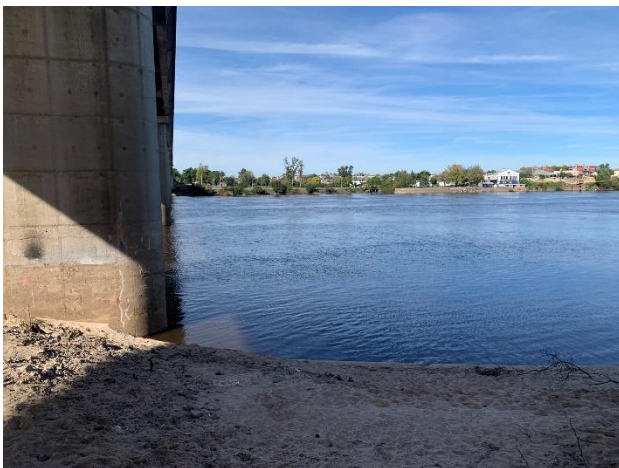
Foto 12.2-9, P01. Cauce del Río Negro bajo puente de Ruta 2 en buenas condiciones de limpieza y escurrimiento natural.
