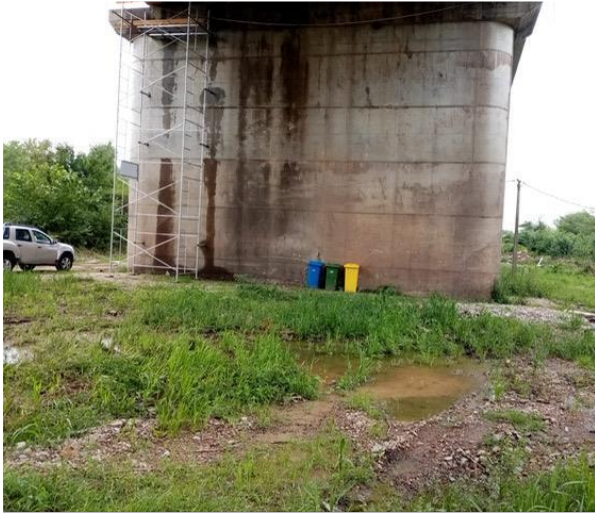
Foto 12.3-1, P01. Nueva infraestructura para acopio temporal de residuos de forma apegada al PGA.
