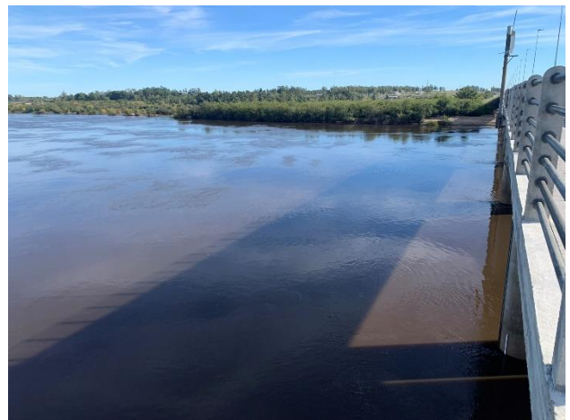
Foto 12.2-10, P01. Cauce del Río Negro bajo puente de Ruta 2 en buenas condiciones de limpieza y escurrimiento natural.
