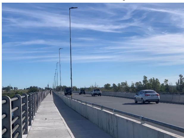
Foto 12.2-3, P01. Ciclovía y senda peatonal terminadas.
