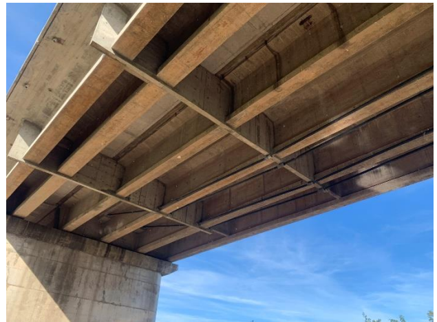
Foto 12.2-8, P01. Obras terminadas de refuerzo estructural y unificación de puentes carretero y ferroviario.
