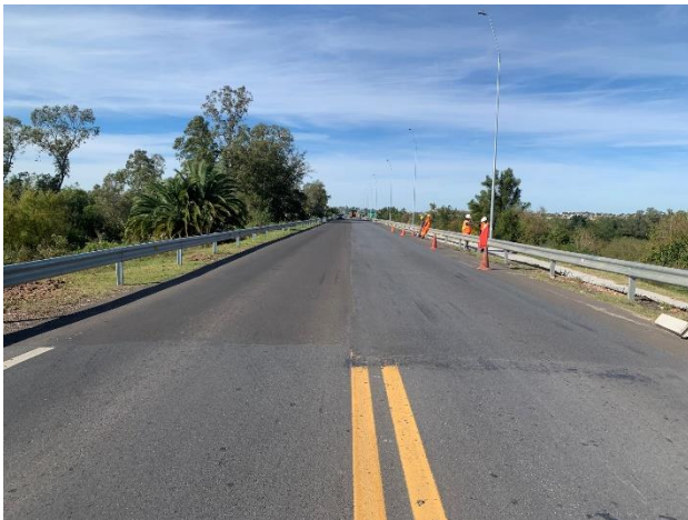
Foto 12.2-5 P01. Acceso a cabecera Norte del puente de Ruta 2 sobre el Río Negro.
