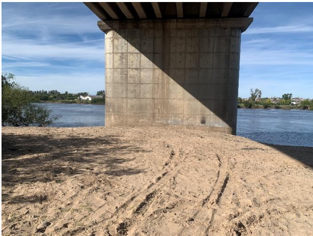
Foto 12.2-7, P01. Planicie de inundación limpia, libre de ROCs u otros residuos.
