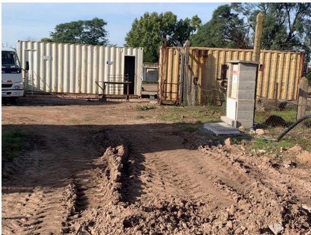
Foto 12.1-3, P02. Contenedores de oficinas permanecen en predio obrador, a ser desmontados en breve.
