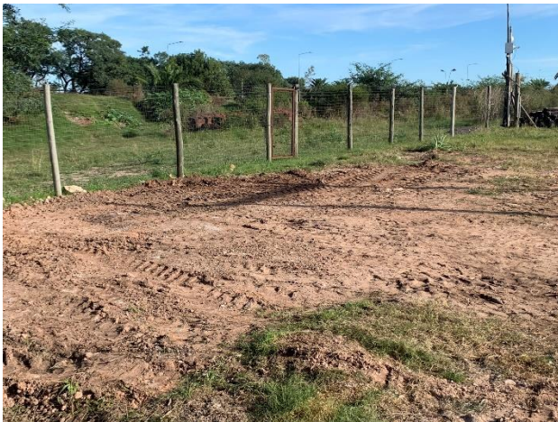
Foto 12.1-5, P02. Pozo impermeable de aguas servidas vaciado, demolido y relleno.
