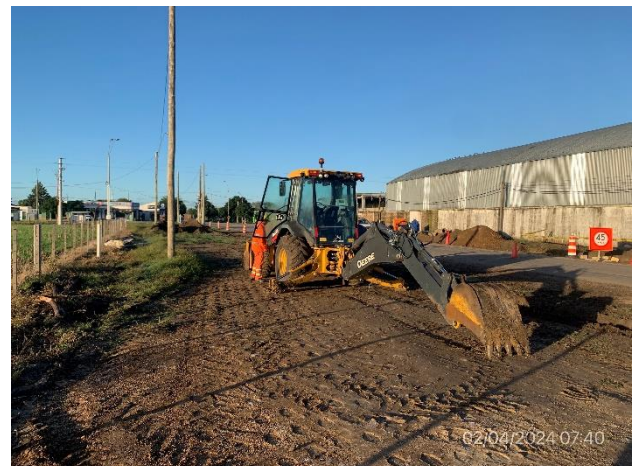
Foto 12.2-4, P03. Tapada de servicios relocalizados en ejecución.
