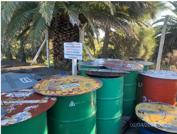
Foto 12.1-5 P04. Obrador, sector envallado con pavimento impermeable para acopio de residuos peligrosos.
