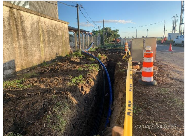
Foto 12.2-2, P03. Zanjeo en ejecución para relocalización de servicios.
