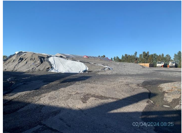
Foto 12.1-2, P04. Obrador, explanada de acopio de agregados.
