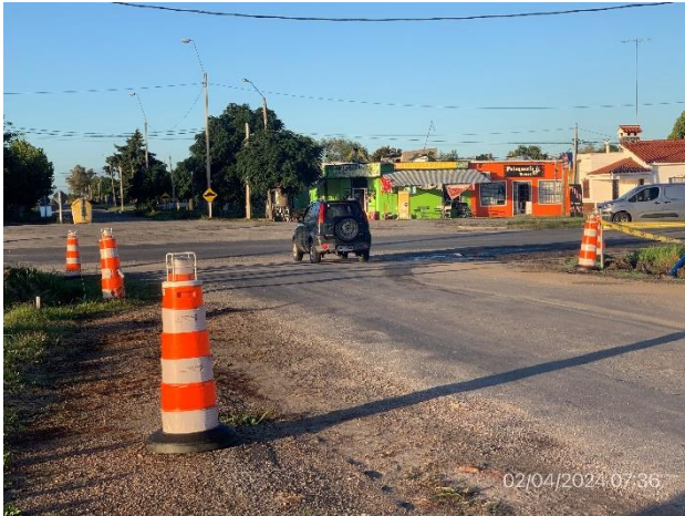
Foto 12.2-1, P03. Frente de obra. Ruta 78 progresiva 17K000. Empalme con Ruta 11 en construcción.
