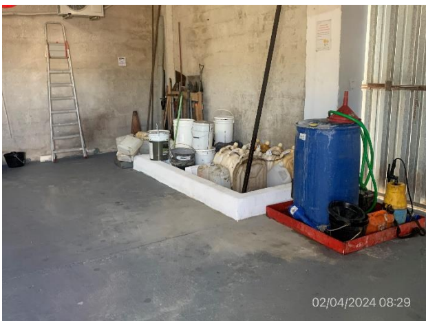
Foto 12.1-9 P04. Obrador, estación de acopio de tarrinas con lubricantes, ubicada en taller.
