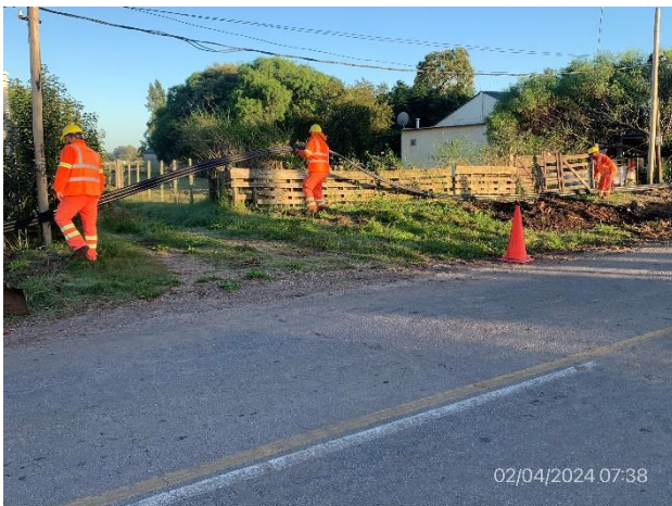
Foto 12.2-3, P03. Tendido de tuberías en ejecución para relocalización de servicios.
